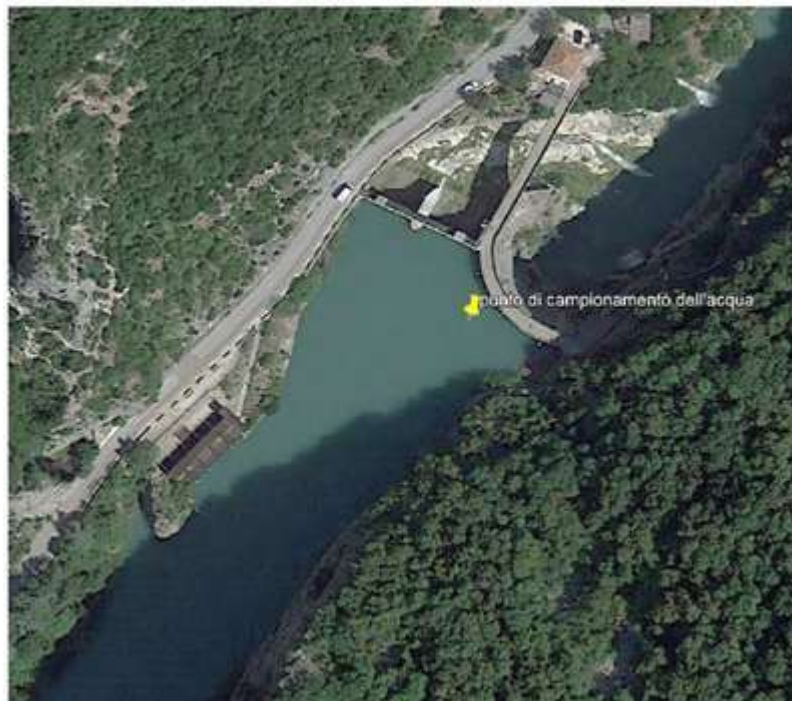
Figura 6.2.2: Ubicazione del punto di campionamento delle acque del bacino
