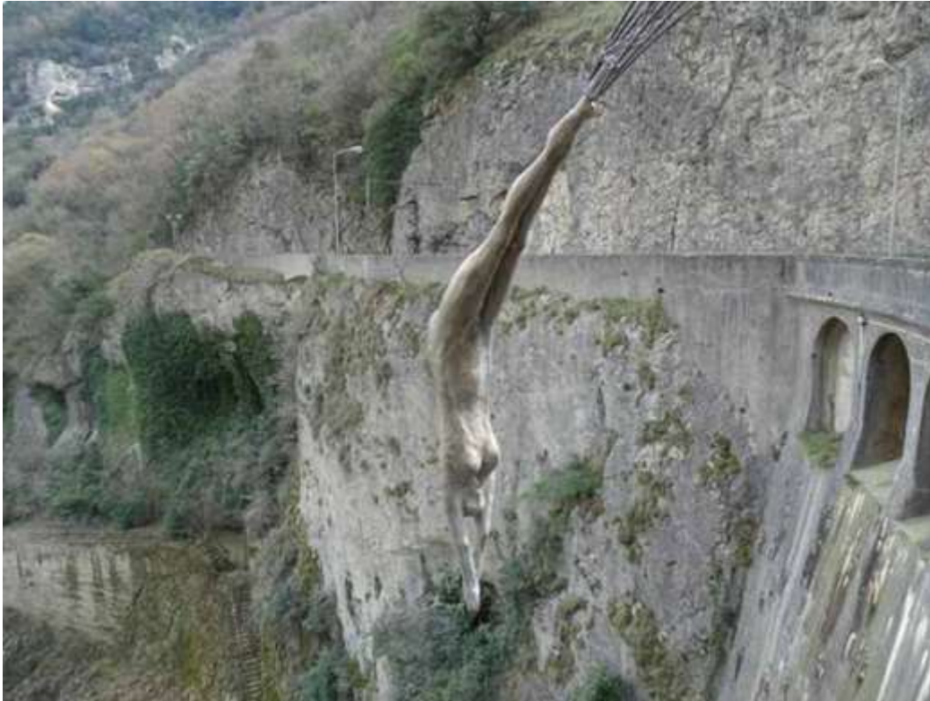
Figura 5 - Opera d'arte installata sul coronamento della diga
