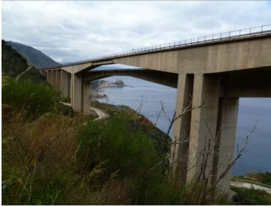
Figura 3: Vista viadotto sulle travi Gerber
