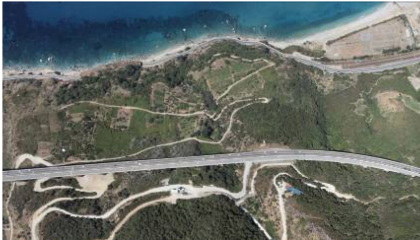
Figura 5: vista aerea del viadotto Carola
