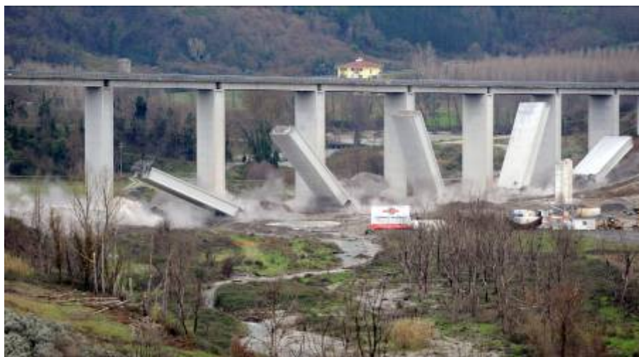
Figura 14: esempio di pile demolite con esplosivo (foto archivio General Smontaggi)
