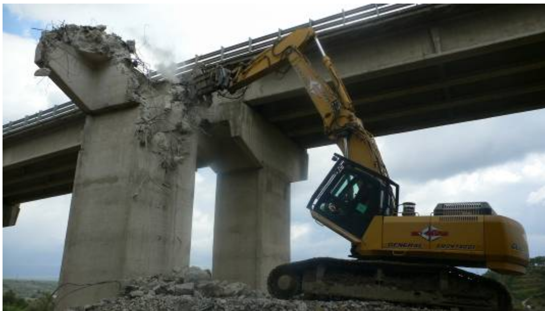
Figura 8: foto esemplificativa demolizione pile con escavatore
