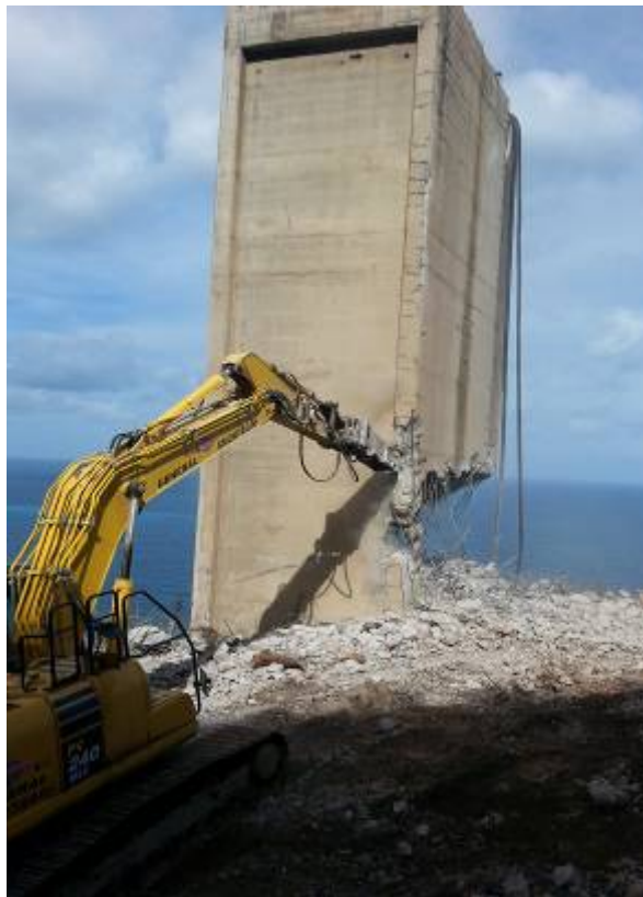
Figura 12: esempio realizzazione di un cuneo di caduta (foto archivio General Smontaggi)
