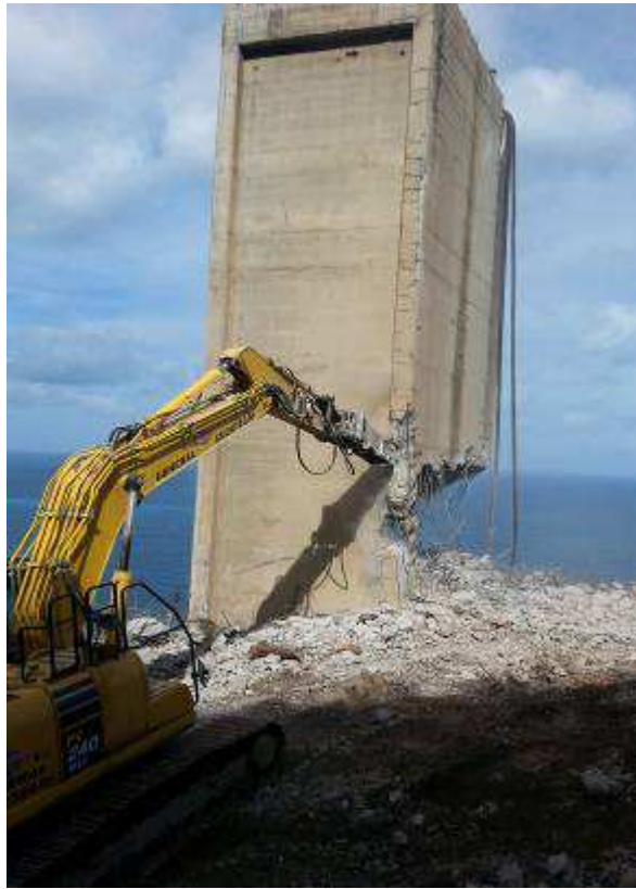
Figura 13: esempio realizzazione di un cuneo di caduta (foto archivio General Smontaggi)
