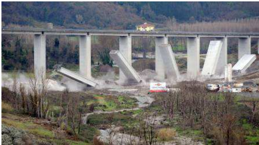
Figura 15: esempio di pile demolite con esplosivo (foto archivio General Smontaggi)
