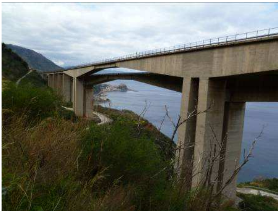
Figura 2: Vista viadotto sulle travi Gerber
