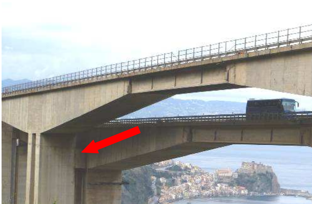
Figura 4: Particolare collegamento strutturale sulle pile a sostegno delle travi gerber
