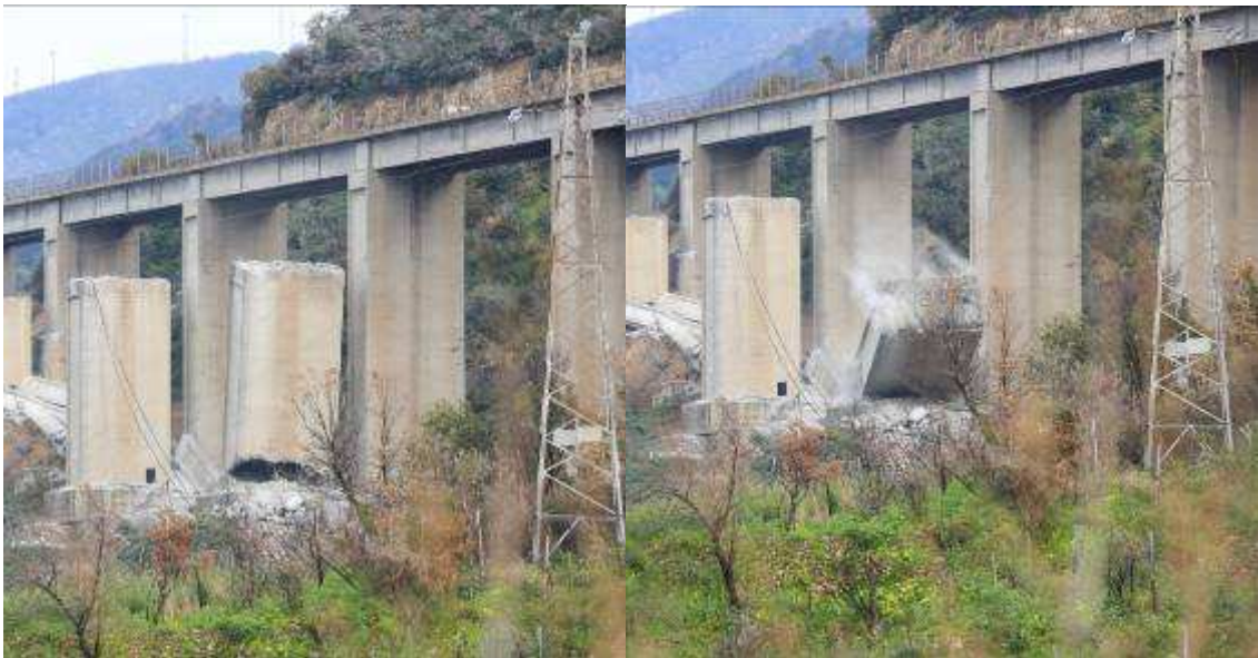
Figura 14: esempio di una pila demolita per crollo indotto (foto archivio General Smontaggi)
