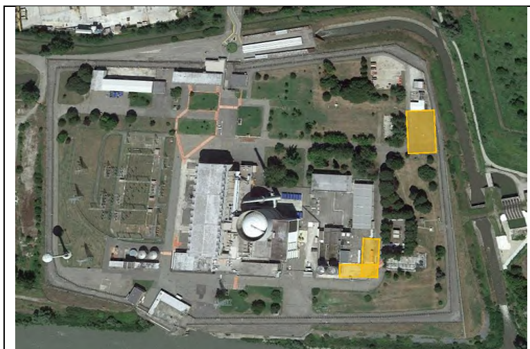
Cantierizzazione Edificio Test Tank
