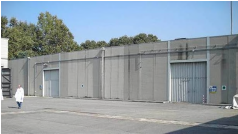
Figura 2-4 - Foto esterna Deposito D1
