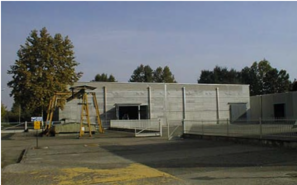
Figura 2-5 - Foto esterna Deposito D 2
