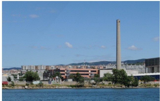
VERSANTE CARSICO OCCLUSO DALL'EDIFICATO
