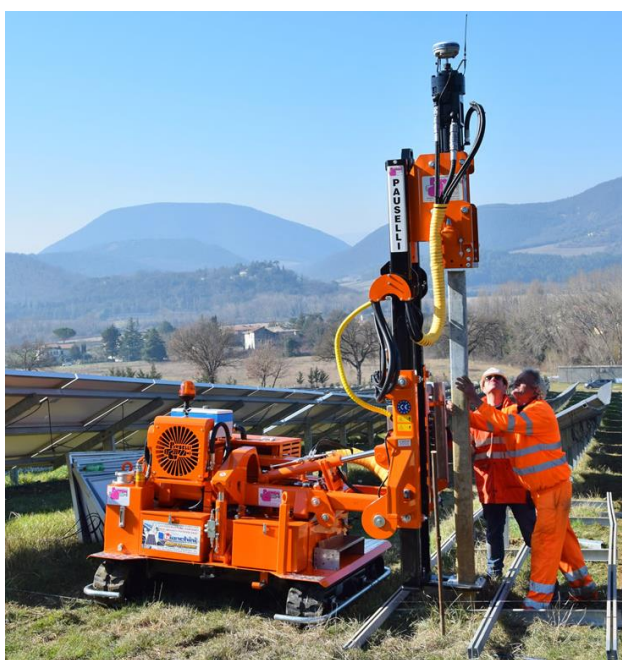
Figura 5 - Infissione dei piedi della struttura monoassiale tramite macchina battipalo
