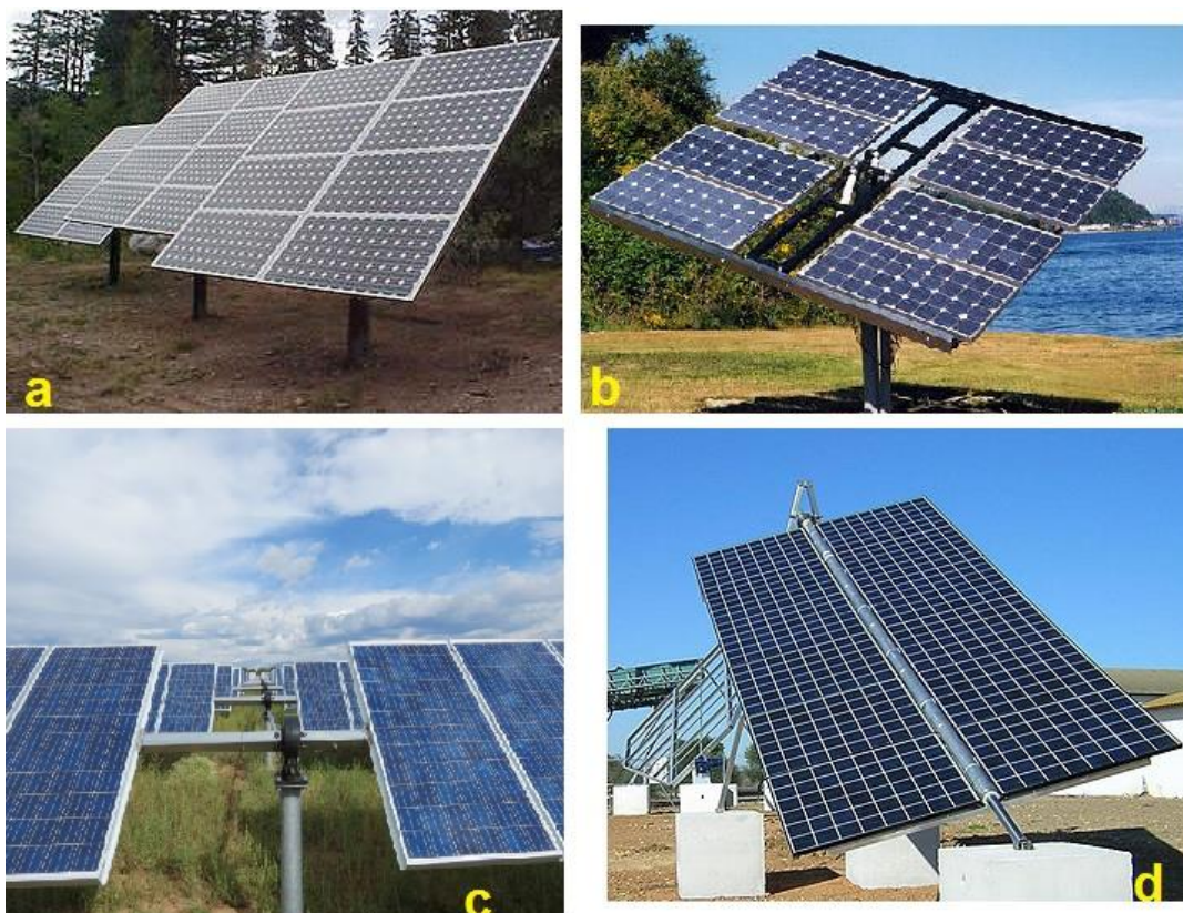
Figura 24 - - Sistemi ad inseguimento: a) inseguitore di tilt, b) inseguitore di azimut, c) inseguitore di rollio, d) inseguitore ad asse polare.
