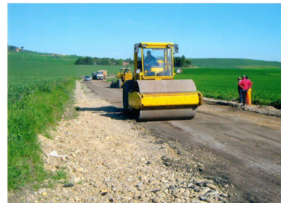
realizzazione strato di usura
