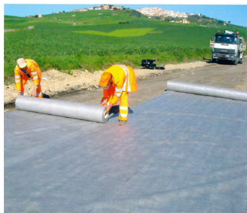
posa geostuoia di separazione
