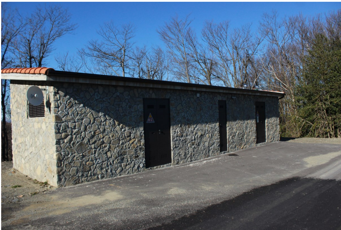
Tipologico di cabina elettrica
