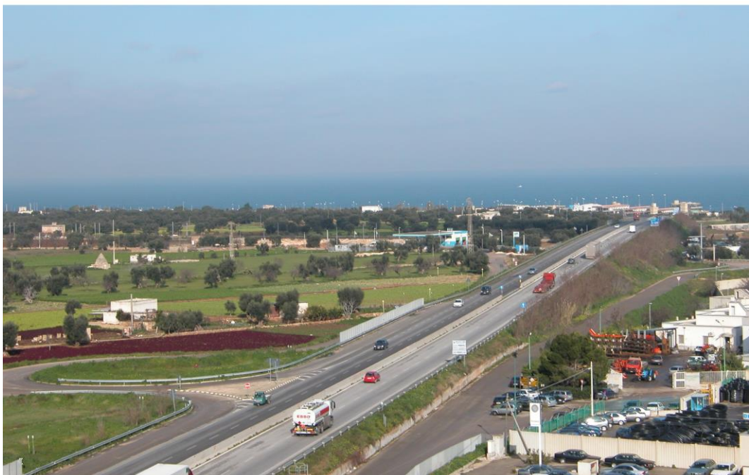
Foto 3.6.3.F – Tratto della Strada Statale n. 16 adiacente al sito d'intervento.
