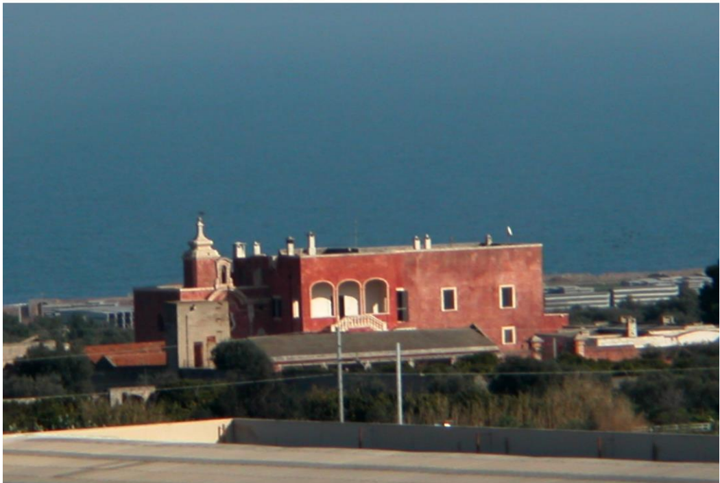
Foto 3.6.3.H – Complesso rurale restaurato appartenente alla Masseria Fortificata Spina.
