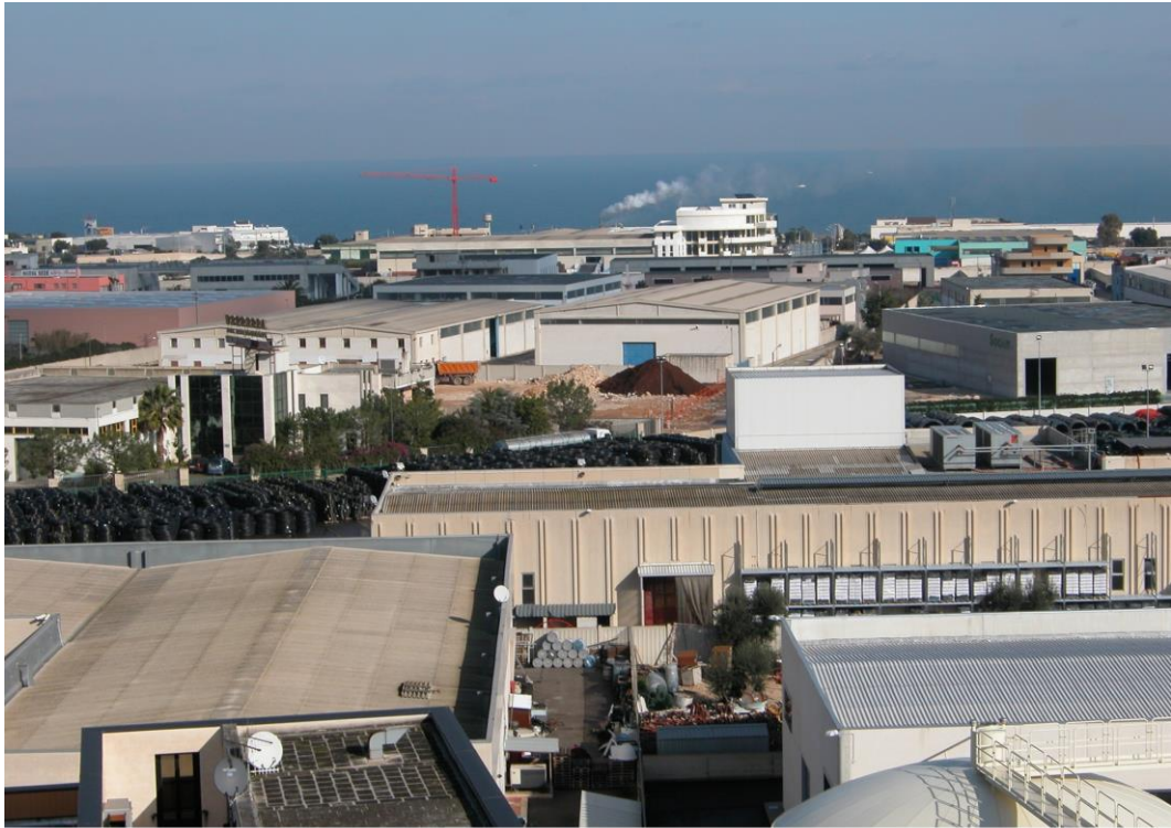
Foto 3.6.3.E – Particolare della Zona Industriale di Monopoli in cui risulta inserito il sito d'intervento.
