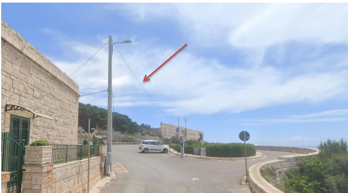
Linee elettriche aeree in corrispondenza dell'aiuola da demolire
