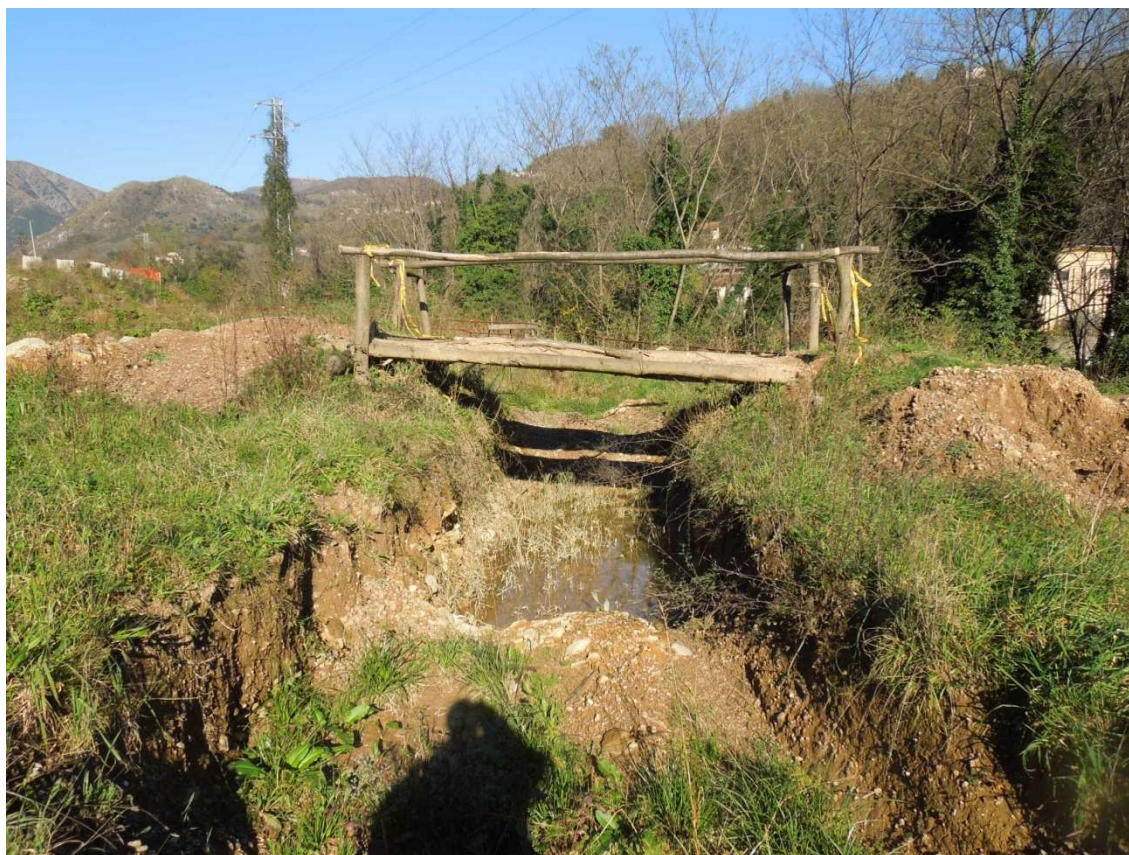
Fig. 3.4 – Rimodellamento dell'area di cantiere per la creazione di una pista.
