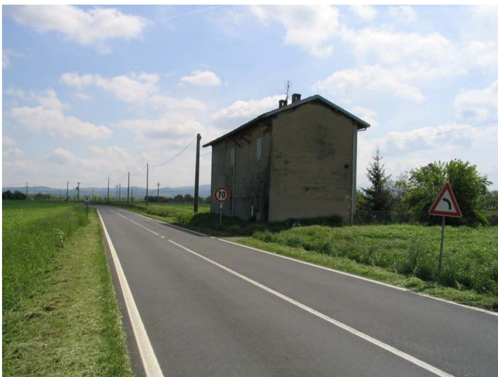
FOTO 3 – Cantiere COP8 Interconnessione per Torino
