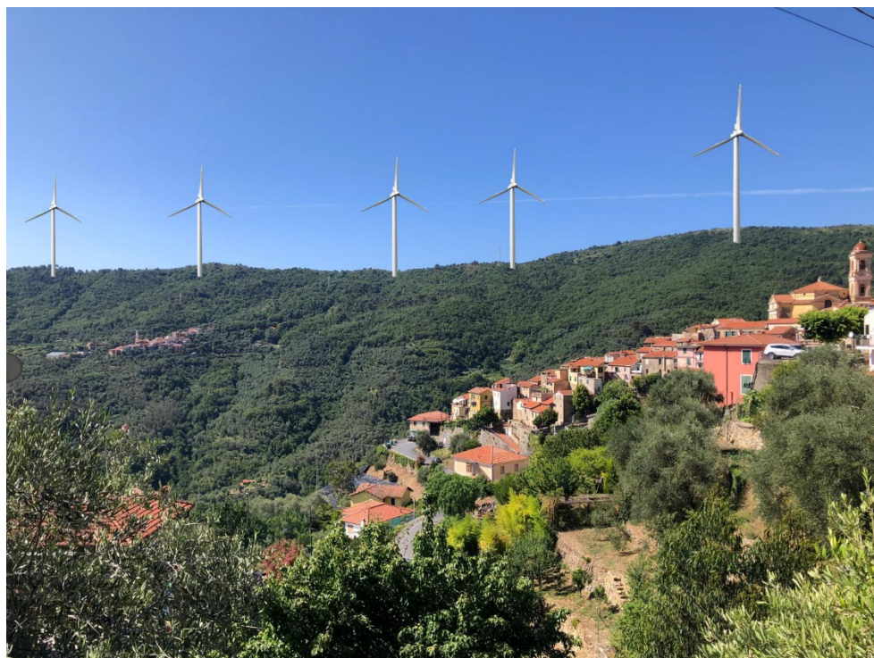
Figura 7 - Pietrabruna e Boscomare dopo l'installazione degli aerogeneratori
