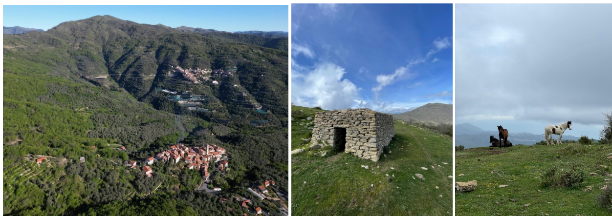
Figura 8 – A sinistra, un'immagine del Monte Follia, con ai piedi Pietrabruna e di fronte (in primo piano) la sua frazione Boscomare. Al centro, il crinale in prossimità dello stesso monte, dove si possono incontrare le “caselle” (chiamate anche “baracche de pria”), ovvero antiche capanne di pietra tipiche della Liguria. A destra, un branco di cavalli selvaggi che abita la zona.
