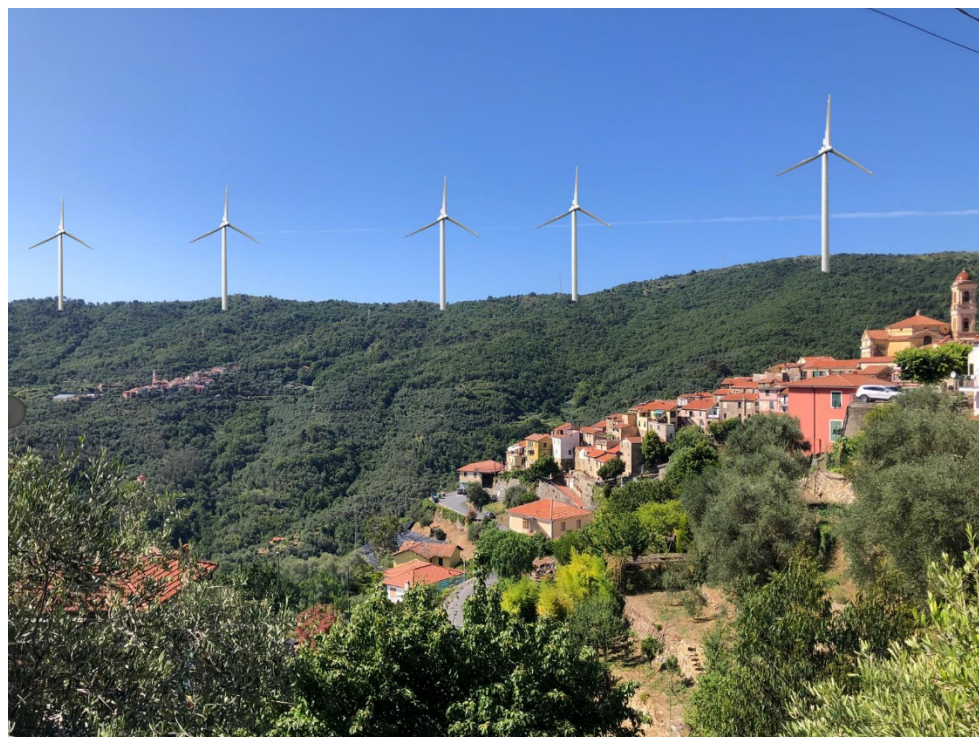
Figura 7 - Pietrabruna e Boscomare dopo l'installazione degli aerogeneratori
