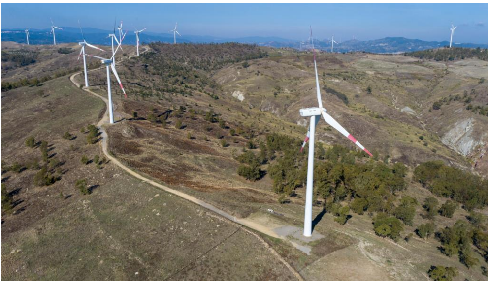
Foto 2 Foto dell'attuale impianto di Melissa Strongoli
