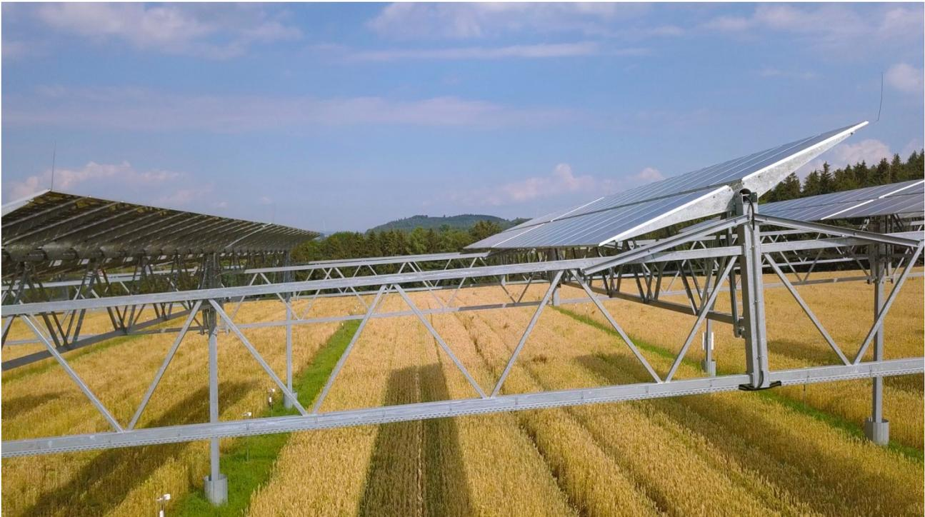
**Figura 3.** Impianto agrivoltaico a Heggelbach (DE)
