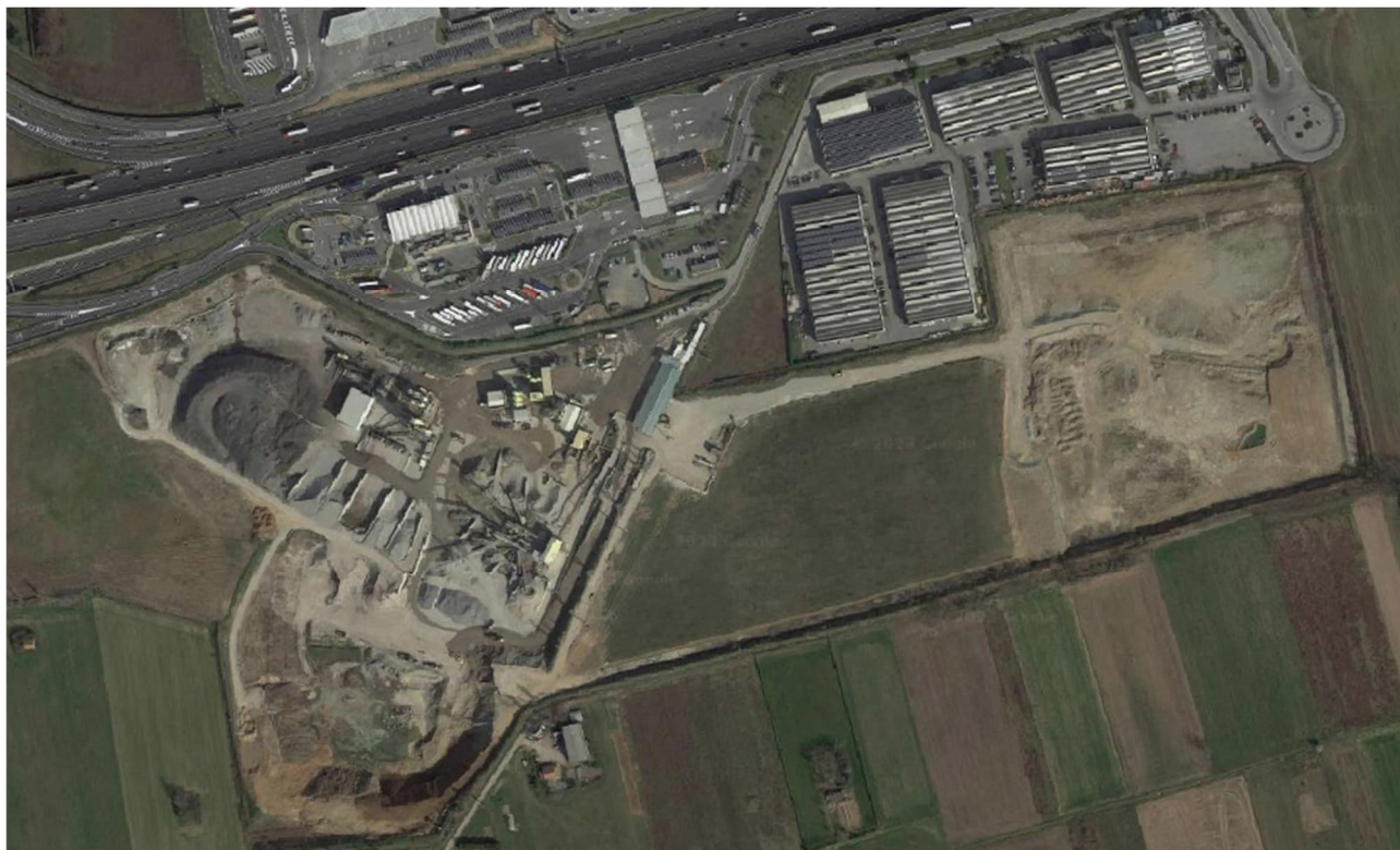
Figura 5-1 – Ortofoto dell'impianto e dell'area di cava di Caponago
