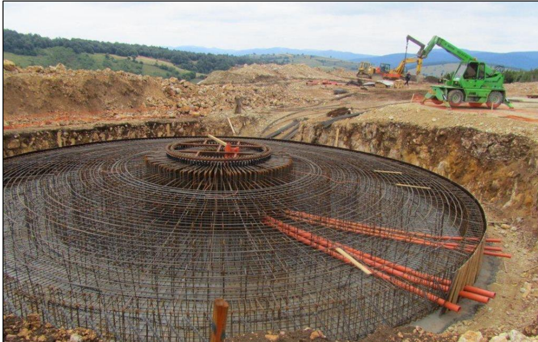
Figura 14 – Fondazione circolare diretta di un aerogeneratore in fase di costruzione
