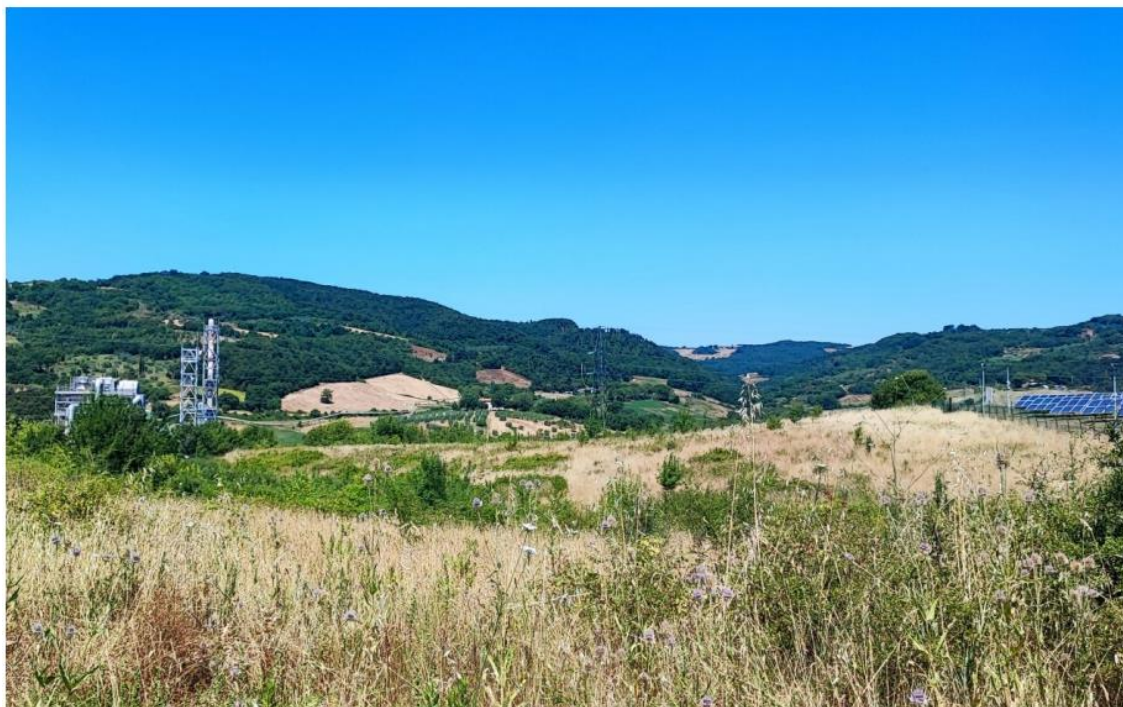
Figura 4-Vista della Centrale Enel Green Power "Cornia 2"
