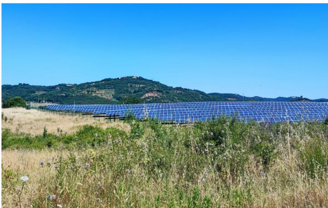
Figura 5-Vista del campo fotovoltaico esistente adiacente alla centrale e all'area oggetto del presente progetto
