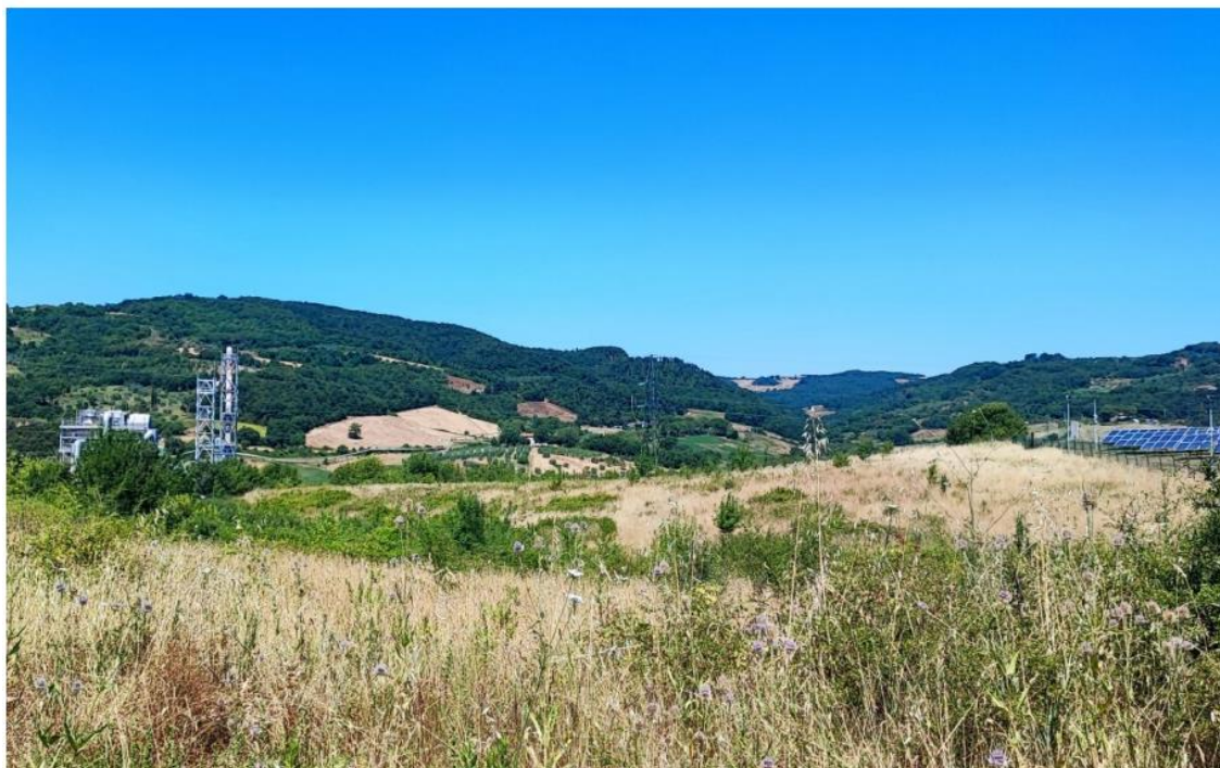
Figura 2.4-Vista della Centrale Enel Green Power "Cornia 2"
