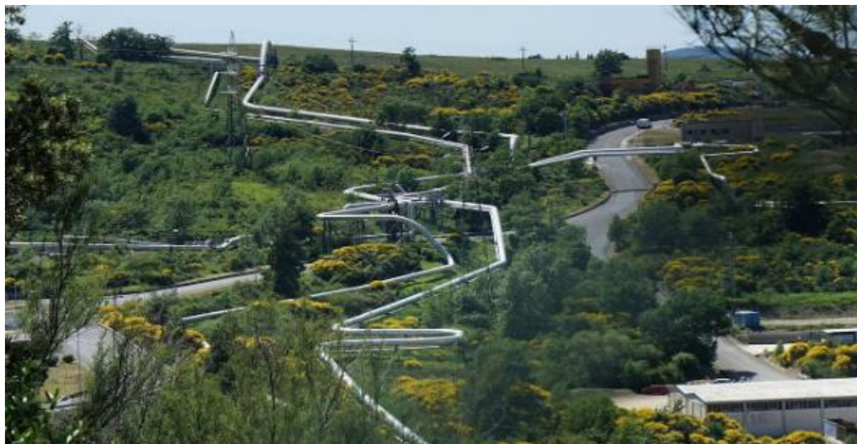
Figura 4 – “Vapordotti” per il trasporto del vapore geotermico dai pozzi di produzione alle centrali.
