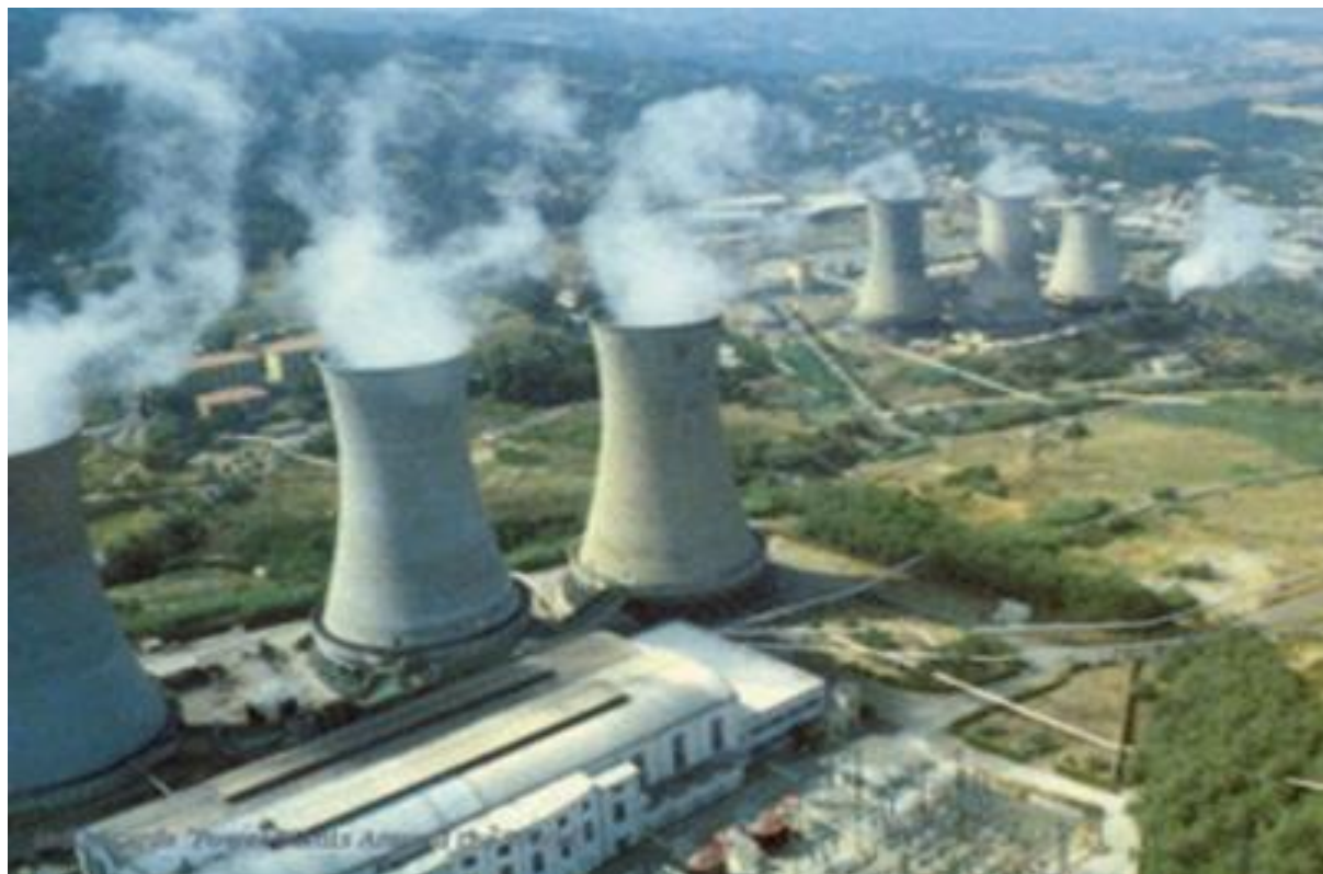
Figura 23 – Centrali con torri refrigeranti
