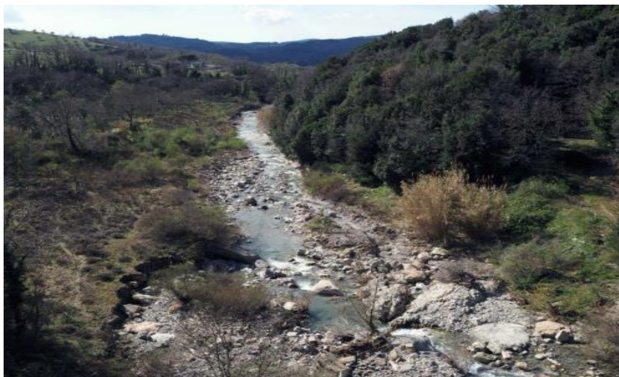
Figura 20 – Panoramica dell'alveo del fiume Cornia
