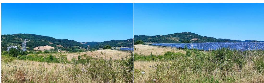
Figura 1.4 Vista della Centrale Enel Green Power "Cornia 2" (n.1, sinistra) e Vista del campo fotovoltaico esistente interno all'area di sito (n.2, destra)
