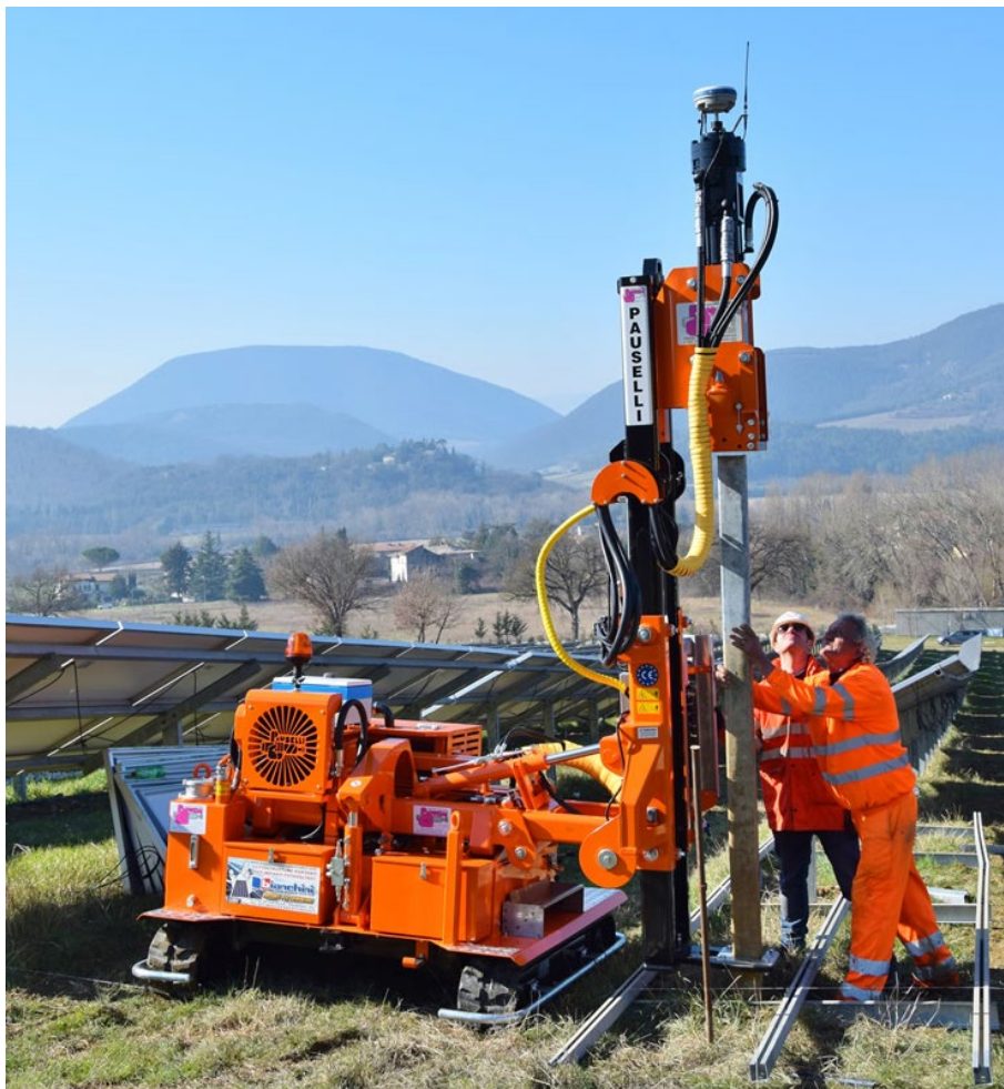
Figura 2 -infissione dei piedi della struttura monoassiale tramite macchina battipalo
