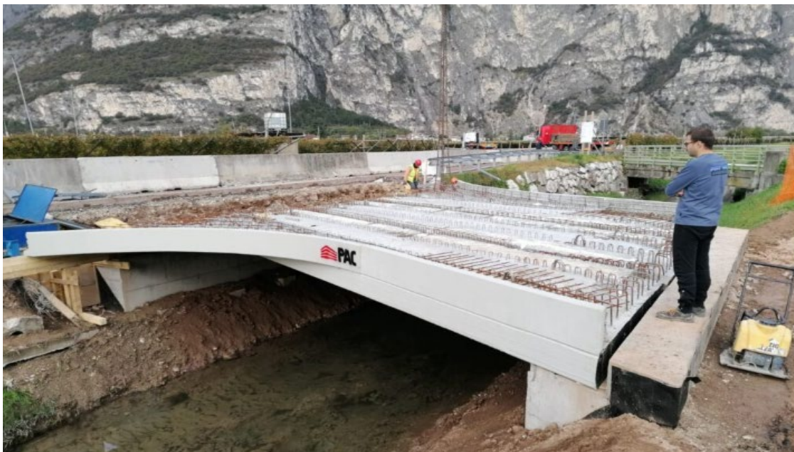
Figura 9: tipologia tipo ponte per attraversamento
