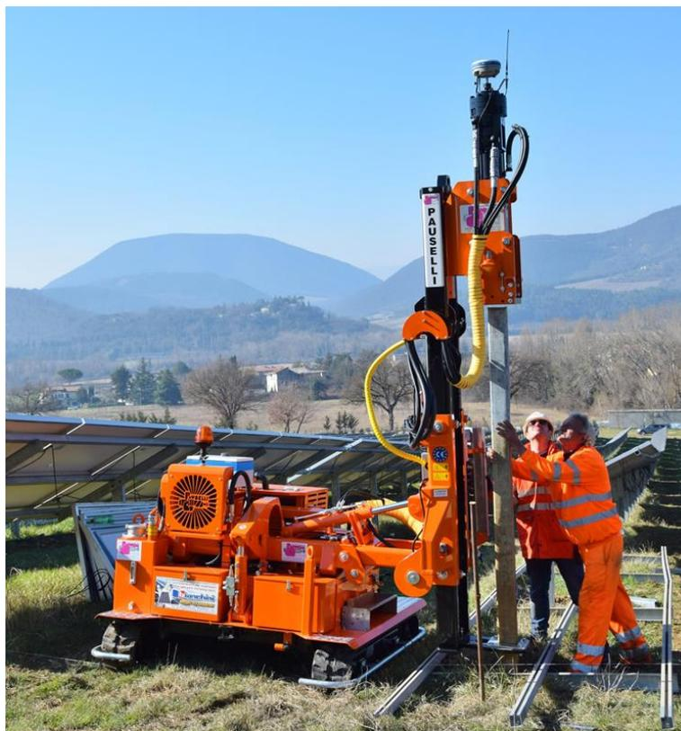
Figura 45 - Infissione dei piedi della struttura monoassiale tramite macchina battipalo
