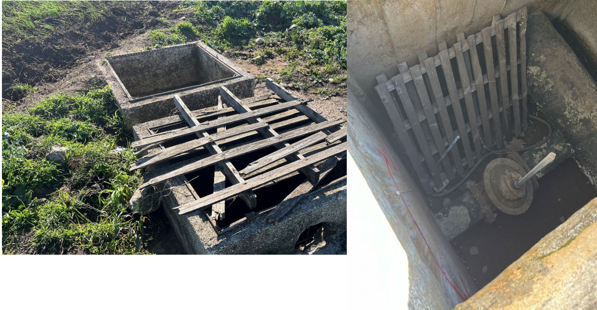
Fig. 4 – A sinistra, il pozzo di ispezione scoperto nei pressi del punto 31. A destra l'interno del pozzo.
