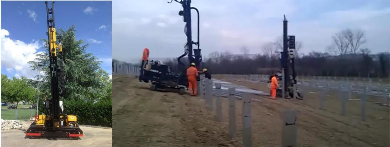
I pali di fondazioni trasmettono il carico al terreno attraverso tensioni tangenziali sulla superficie laterale e tensioni normali alla base o alla punta. Le prime dipendono, oltre che dalle caratteristiche dell'interfaccia palo-terreno e del terreno immediatamente circostante, dallo stato tensionale all'interfaccia; le seconde dalle proprietà di un ridotto volume di terreno circostante e sottostante la punta del palo.
