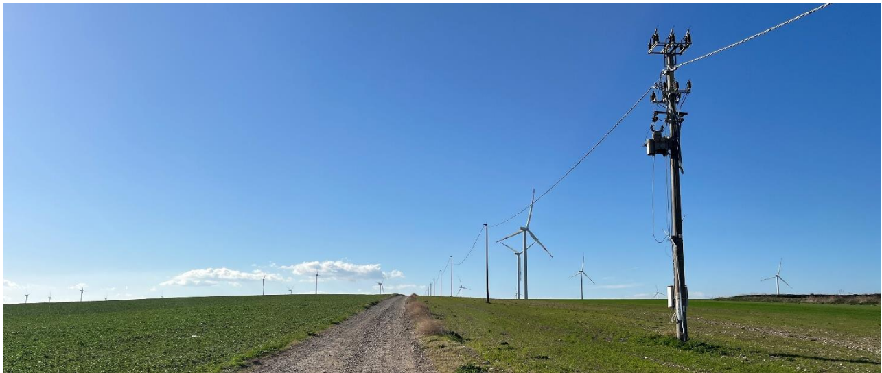
Stato di fatto dal punto di osservazione A
