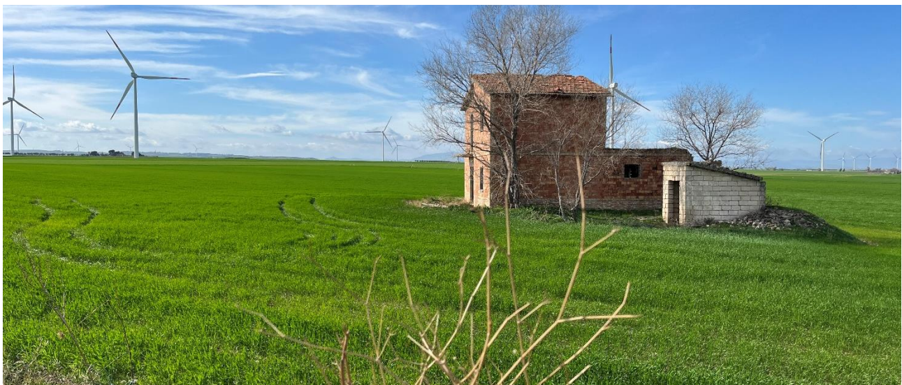
Stato di fatto dal punto di osservazione P
