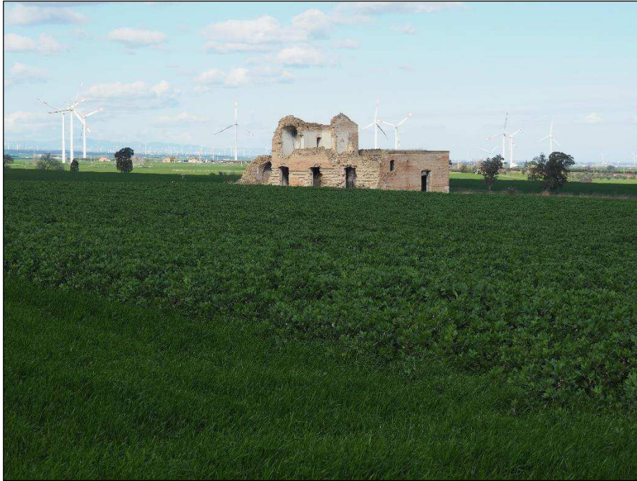
Punto di ripresa_7 – particolare di fabbricato diruto visuale nord-est
