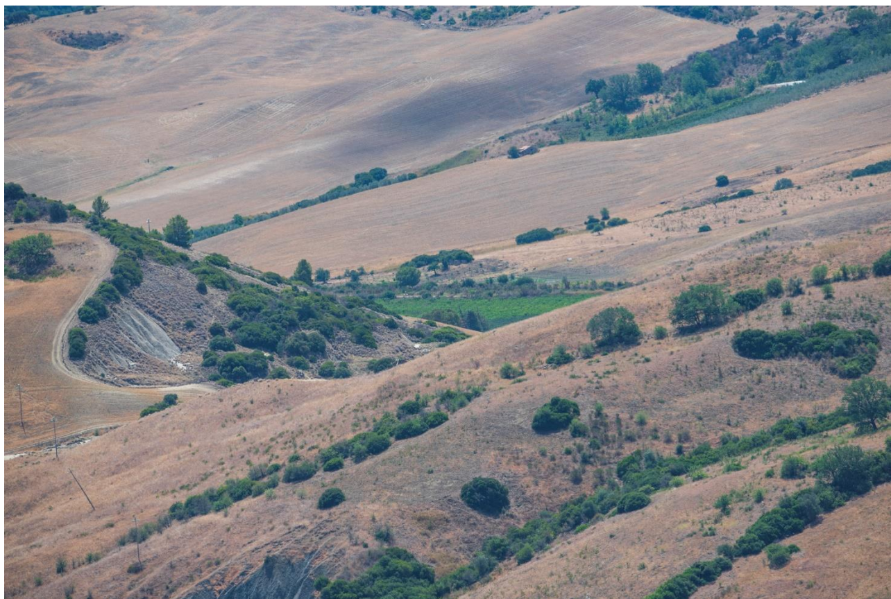
Foto 9.3: Vista su area piazzola di montaggio aerogeneratore IS09
