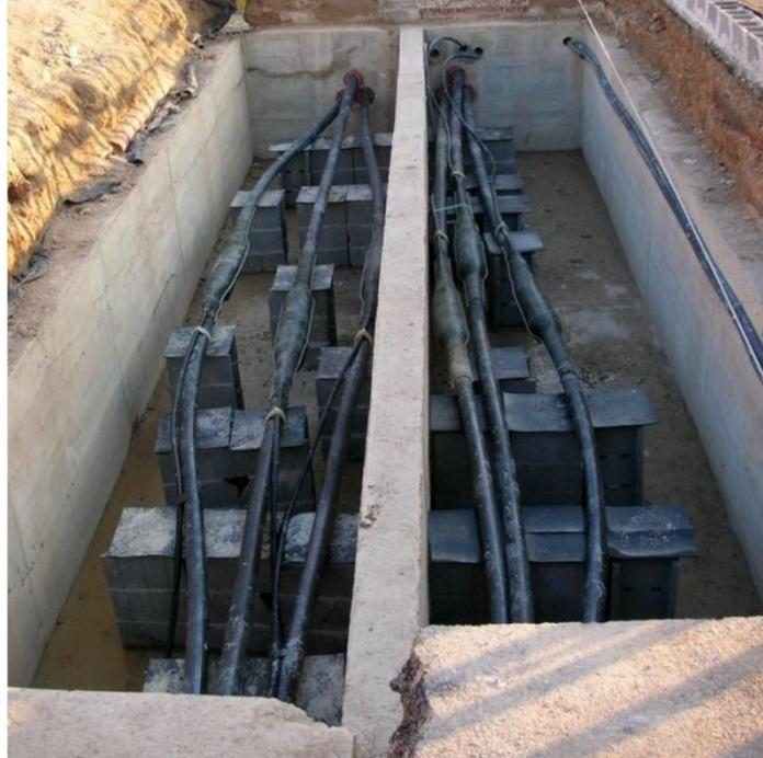
**Figura 54: Immagine tipologica del vano giunti interrato.**
