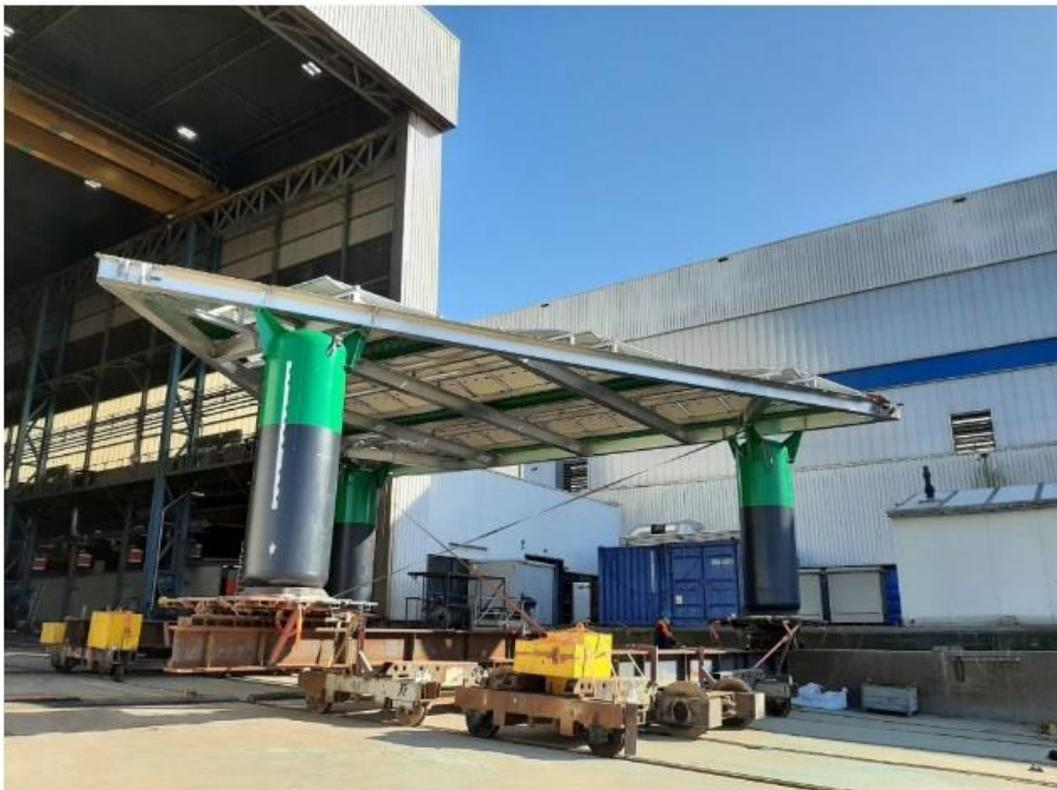
Figura 61: Esempio di assemblaggio in banchina piattaforma triangolare fotovoltaica (fonte: solarduck.tech)
