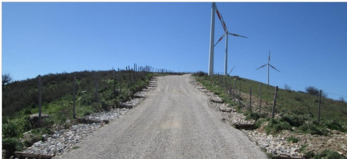
Figura 15-Esempi di sistemi di fossi di guardia con fondo rivestito in pietrame e salti
