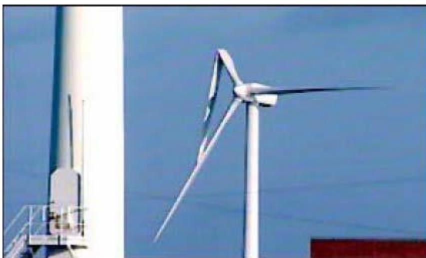
*Figura 7 Esempio di rottura di pala senza distacco.*
