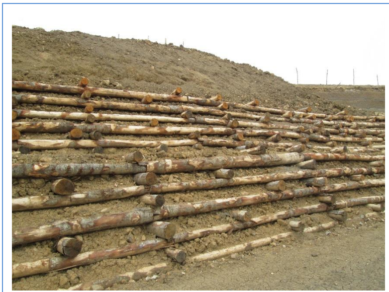
Figura 8.3 – Esempio di opera in palificate in legname - Fonte HE
