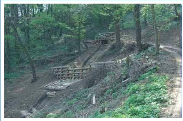
Figura 8.7 – Esempio di briglie in legname e pietrame - Fonte HE
