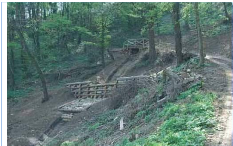
Figura 4-12 – Esempio di briglie in legname e pietrame - Fonte HE
