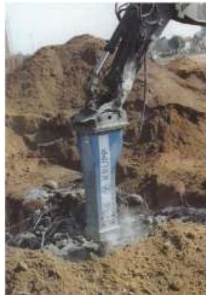
*particolare della porzione di fondazione da demolire mediante martello idraulico*
