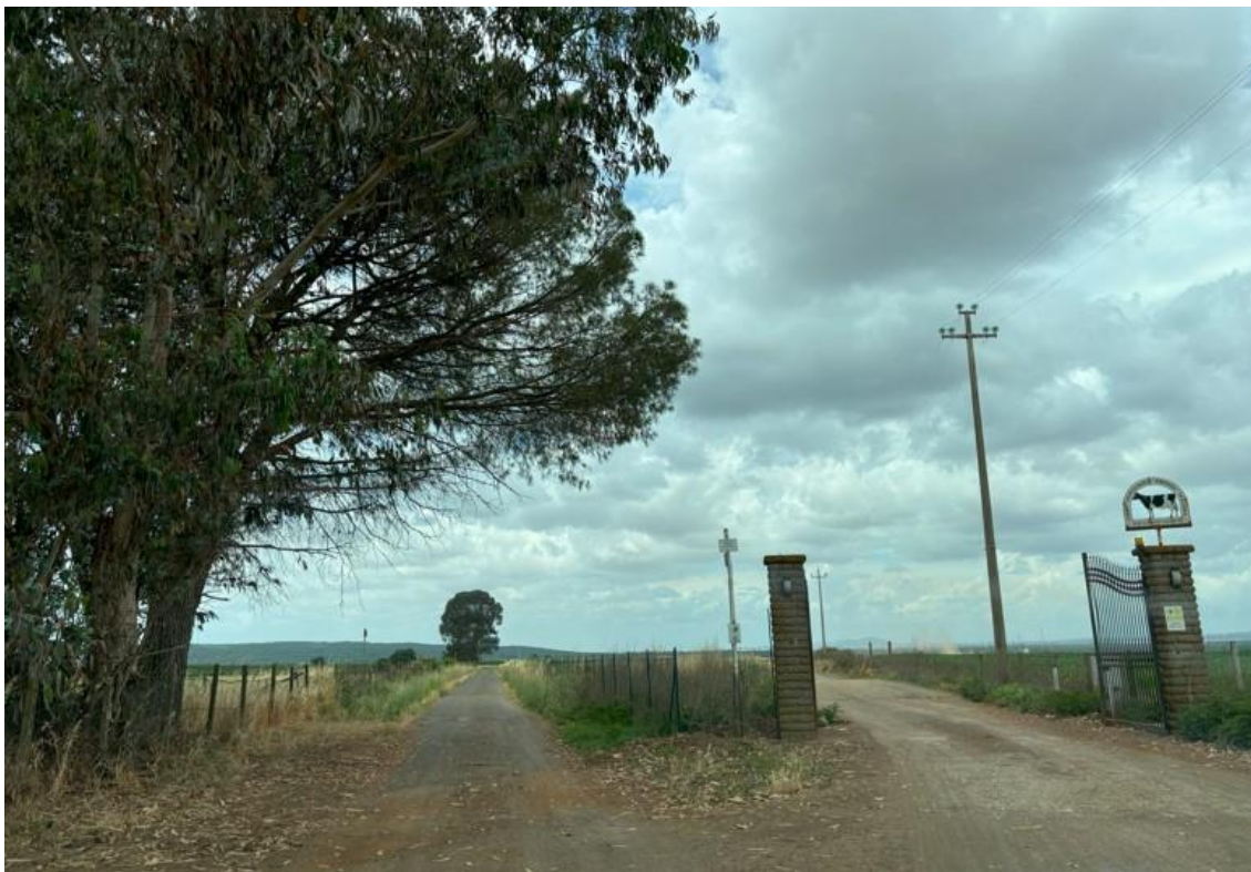
FOTO. Strada Norchia km 6 circa. A destra si entra nella strada non aperta al pubblico da cui, dopo 1,5 km di strada privata, si arriva all'area dell'impianto.
