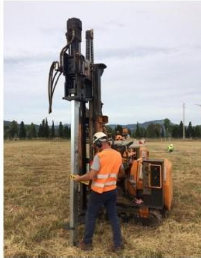
Figura 31. La macchina battipalo per l'infissione nel terreno dei profilati metallici
