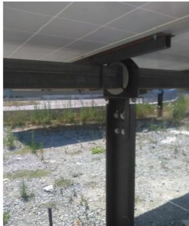
Figura 32. Dettaglio del cuscinetto del tracker che rende possibile la variazione dell'inclinazione
