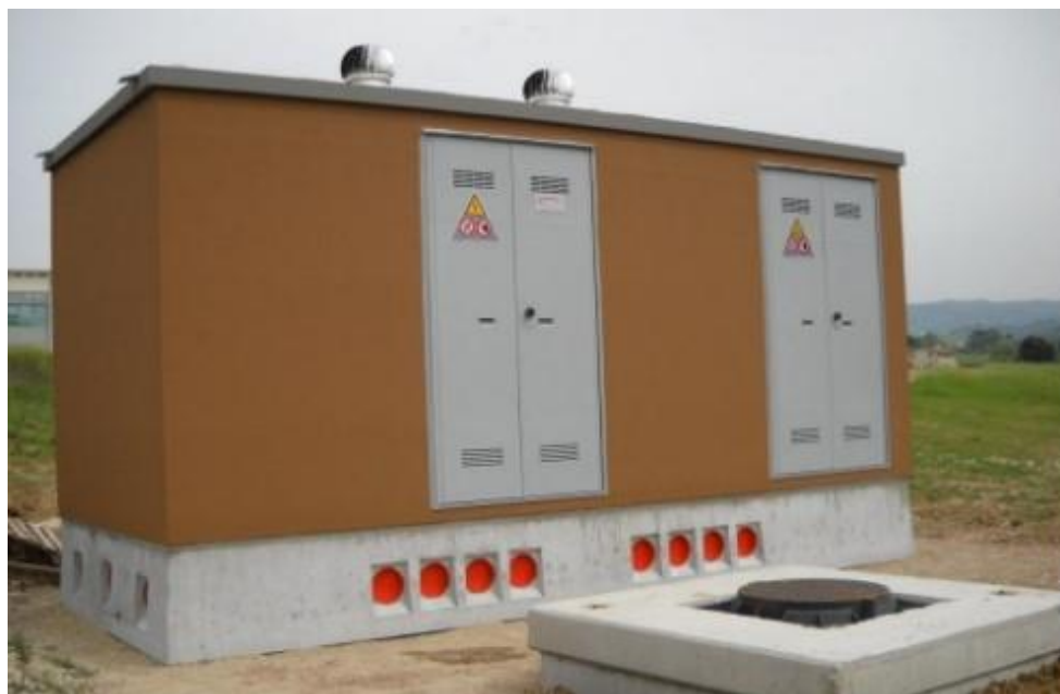
Figura 36. Foto di un esempio delle cabine prefabbricate dell'impianto in c.a.v. (che potranno essere alternativamente utilizzate alle cabine prefabbricate in metallo di cui alla Figura 35
