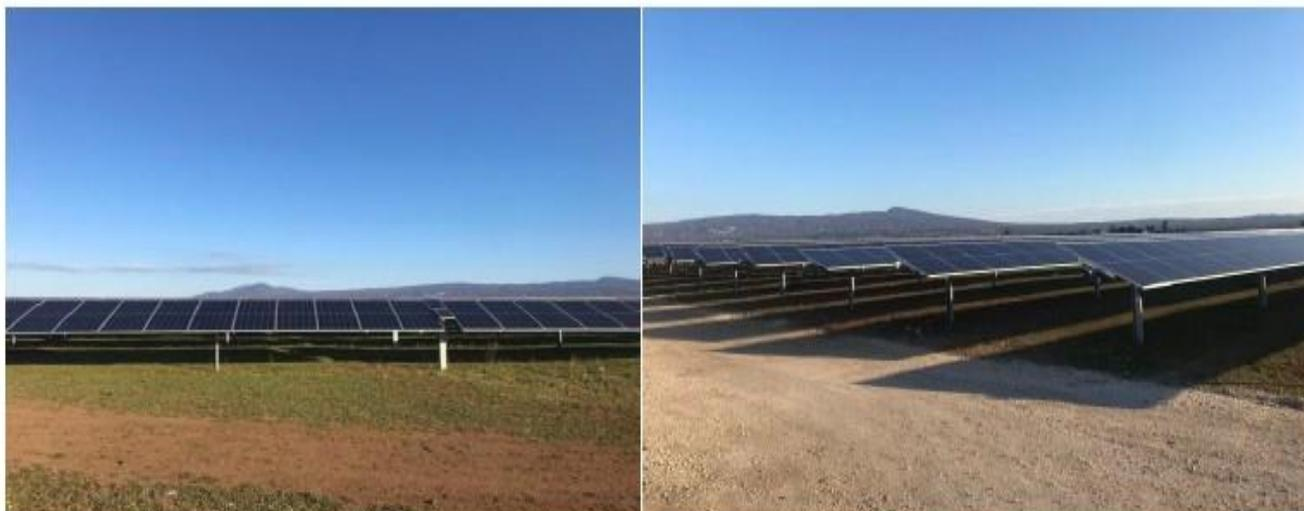
*Figura 29: Esempi di impianti con tecnologia ad inseguimento tracker*
