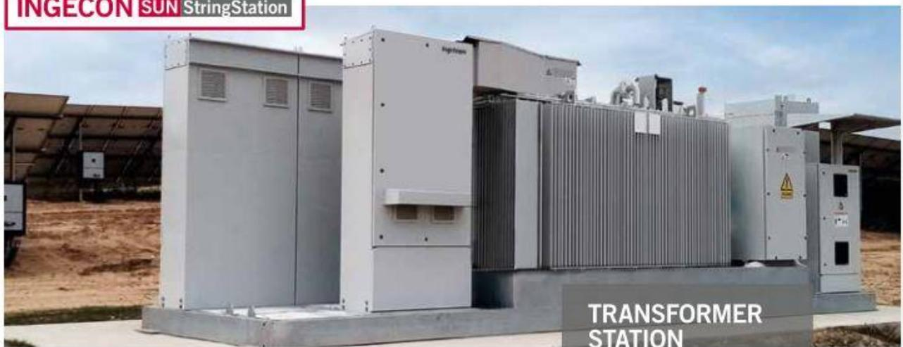
Figura 30. Foto di esempio delle cabine prefabbricate dell'impianto in c.a.v. o in metallo del tipo Solar Transformer Station)
