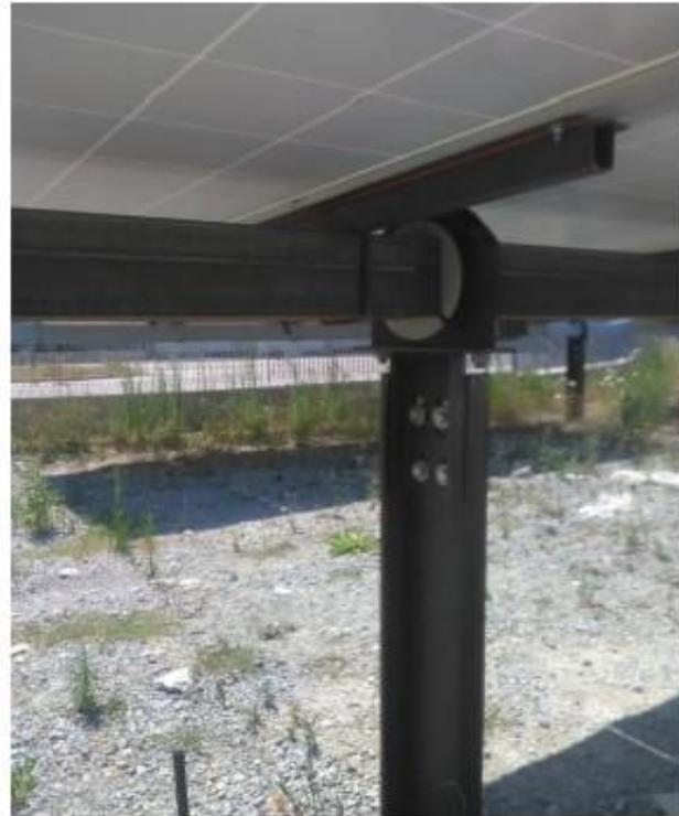
*Figura 5. Dettaglio del cuscinetto del tracker che rende possibile la variazione dell'inclinazione*
