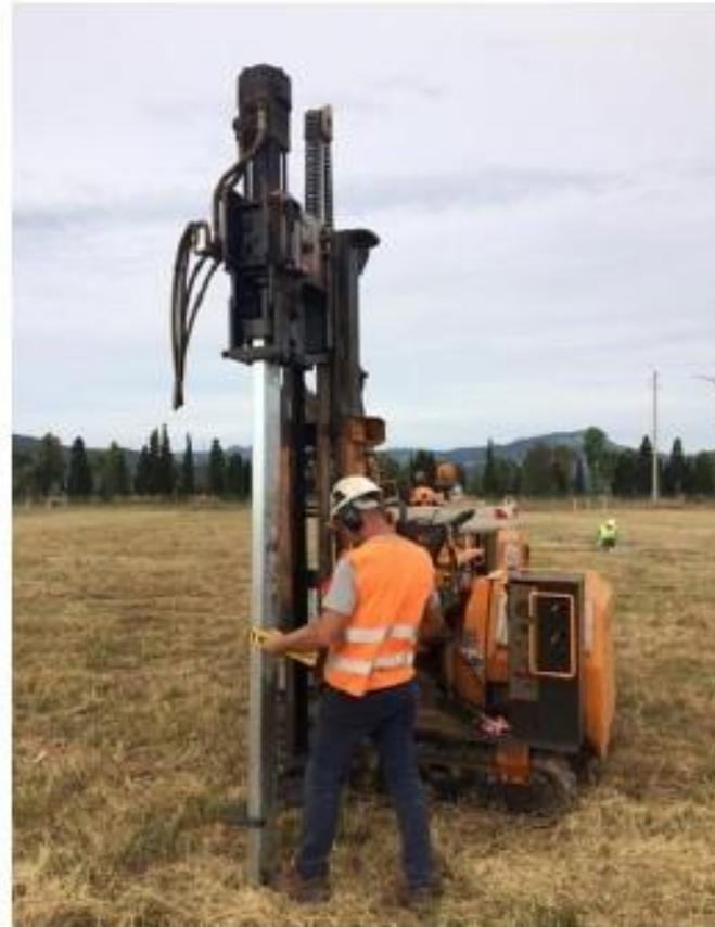
*Figura 4. La macchina battipalo per l'infissione nel terreno dei profilati metallici*
