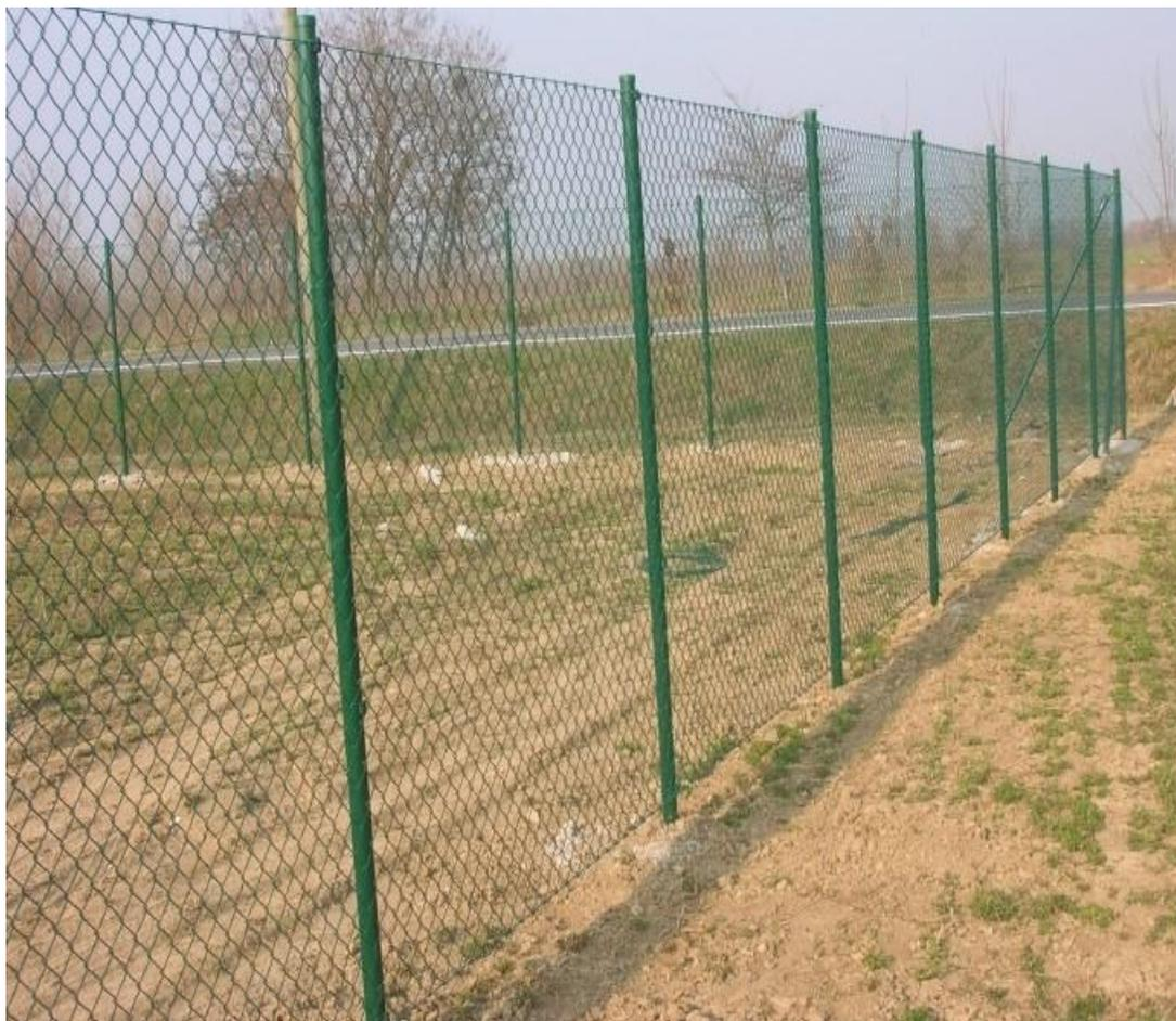
*Figura 11: Esempio della recinzione di progetto alta 200-220 cm*
