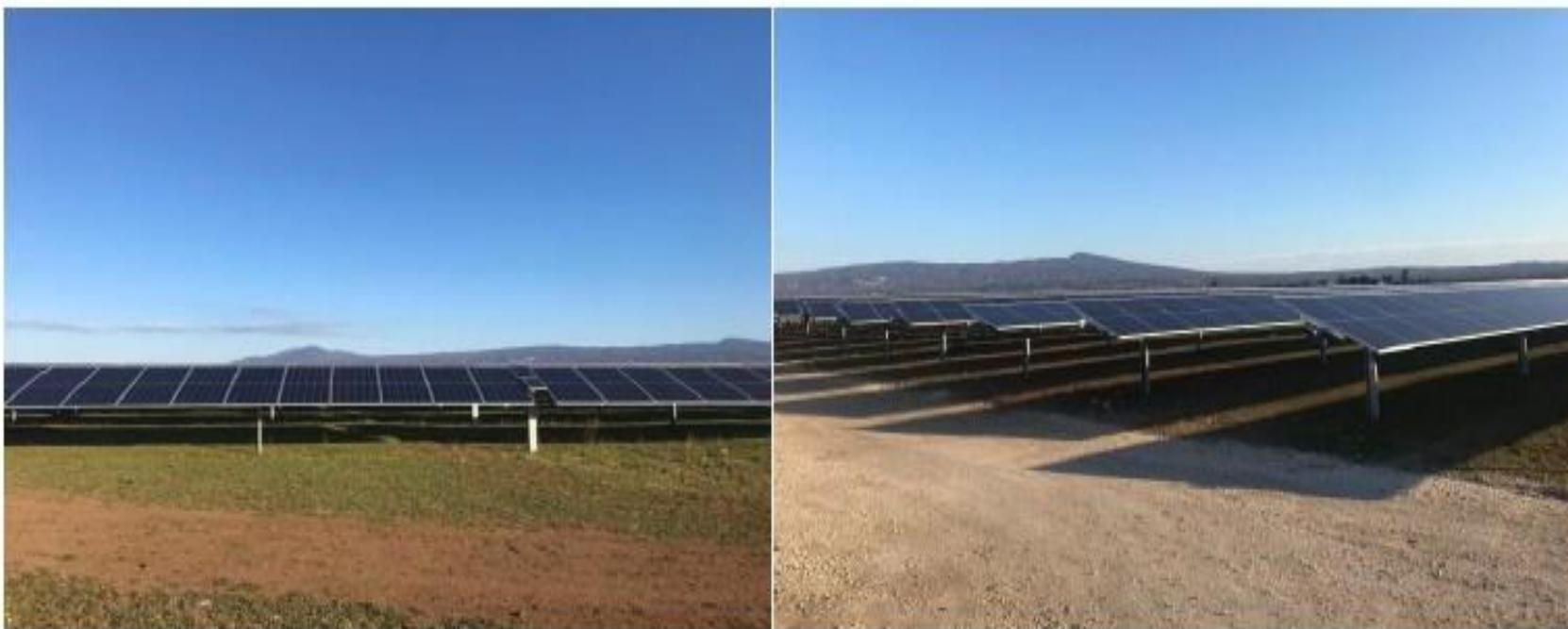
*Figura 6: Esempi di impianti con tecnologia ad inseguimento tracker*
