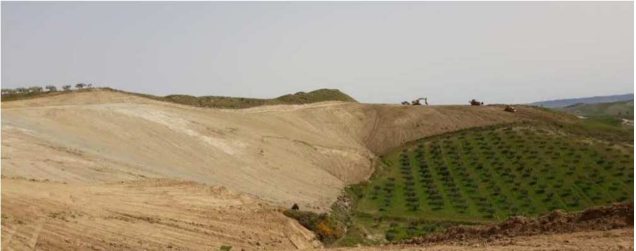
Figure 49 Foto 3 del nuovo accesso utilizzato dalle macchine
