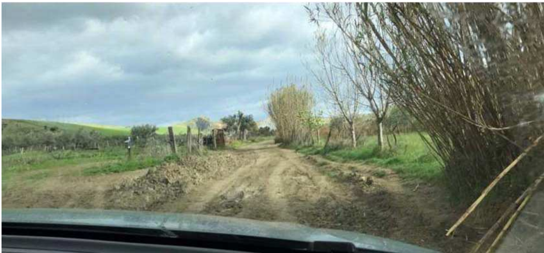
Figura 9 Strada comunale asfaltata/sterrata (nei pressi dell'ingresso CA03, punto 5 della precedente figura 4)
