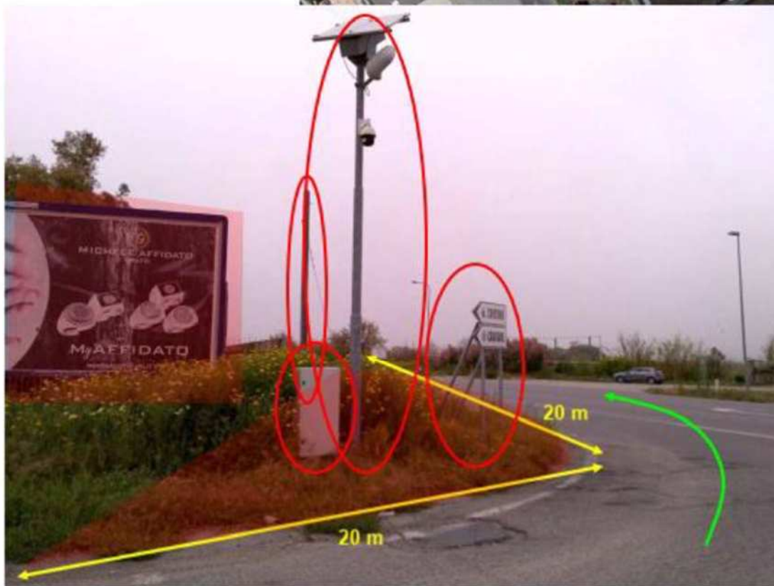
Fig.26-Rimozione ostacoli ed allargamenti sede viaria
