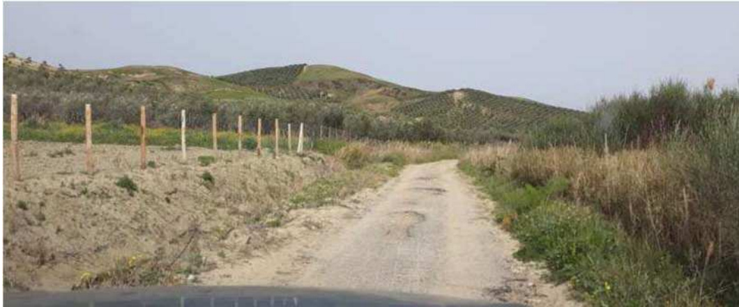
Figura 8 Strada comunale asfaltata/sterrata (nei pressi dell'ingresso CA10-CA07, punto 4 della precedente figura 4)
