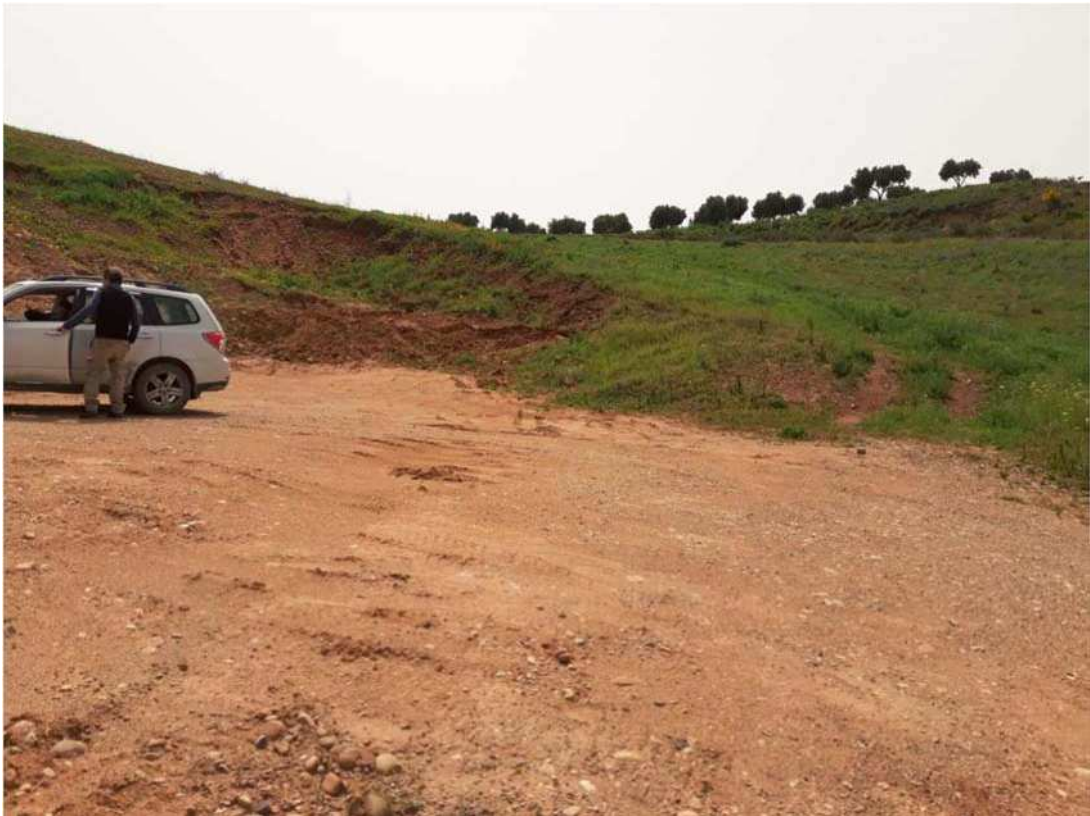
Figure 73 e 74 Lavori di scavo nella zona di riempimento della piattaforma e zona di un percorso esistente verso la posizione di CA10
