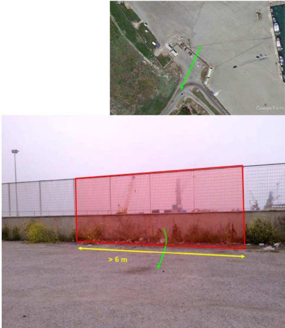
Fig.18-Demolizione Recinzione porto di Crotona
