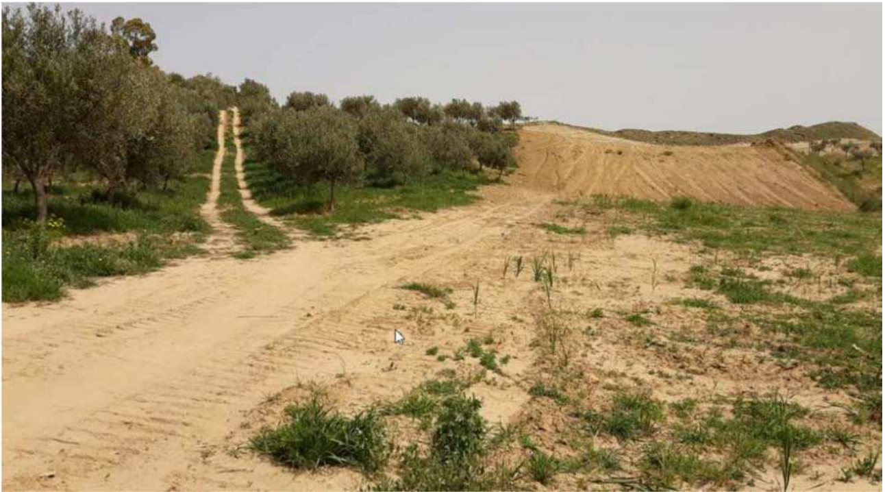
Figure 47 Foto 1 del nuovo accesso utilizzato dalle macchine.
