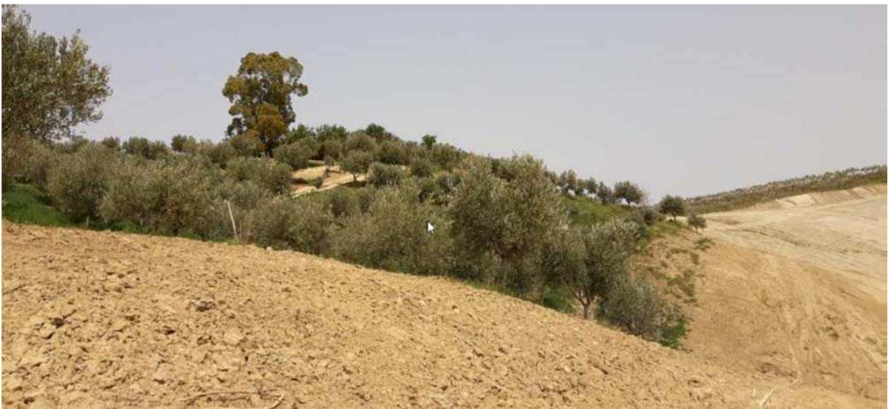
Figure 48 Foto 2 del nuovo accesso utilizzato dalle macchine
