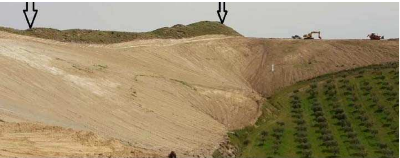
Figura 56 Posizione WTG CA9 dal lato sud (punto fotografico 2)
