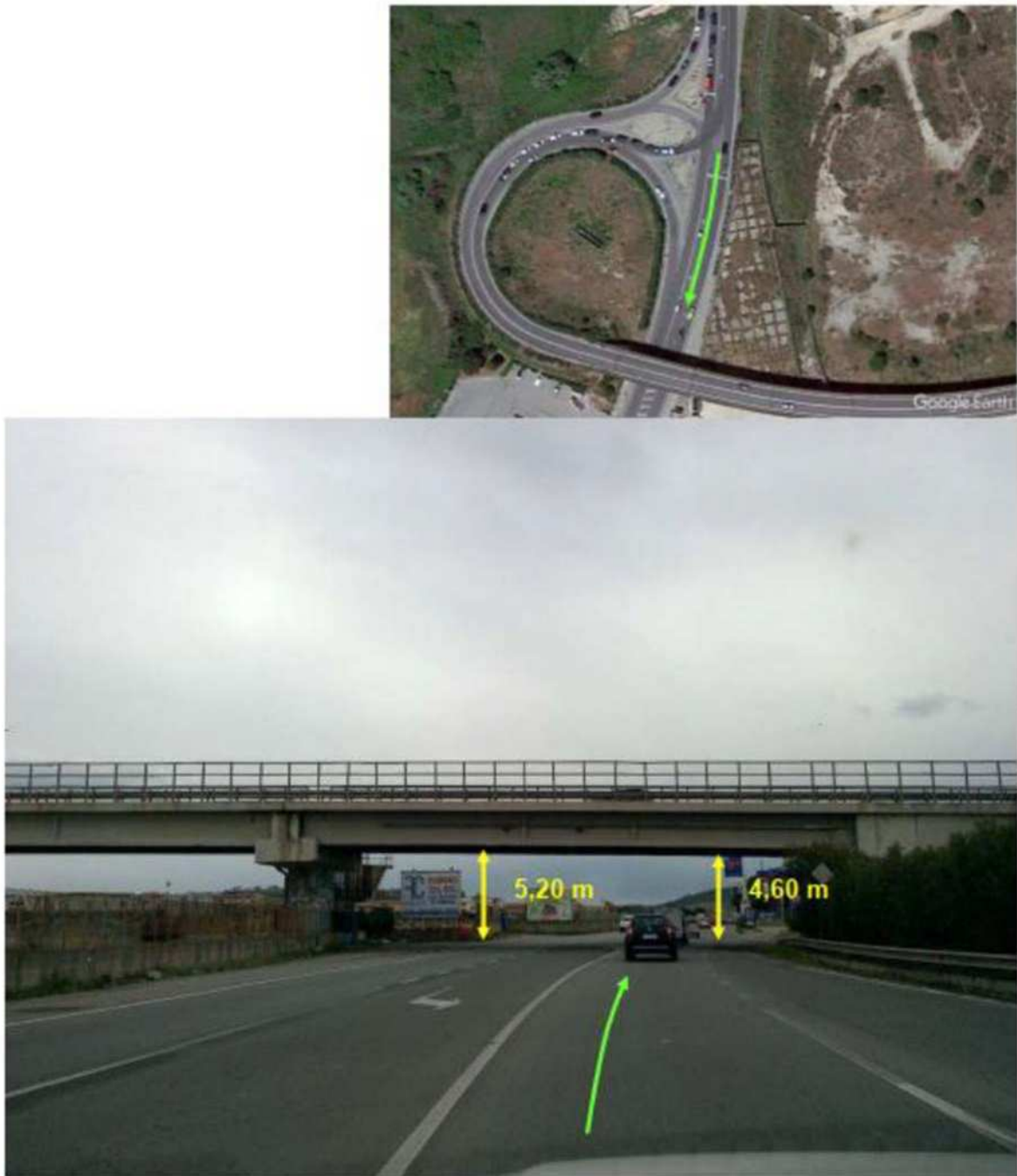
Fig.28- Ostacolo luce libera ponte su SS106
