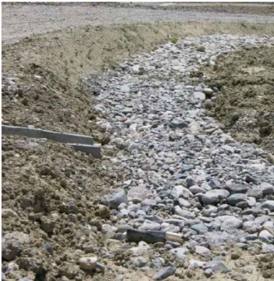
Foto 1: Drenaggi acque meteoriche
