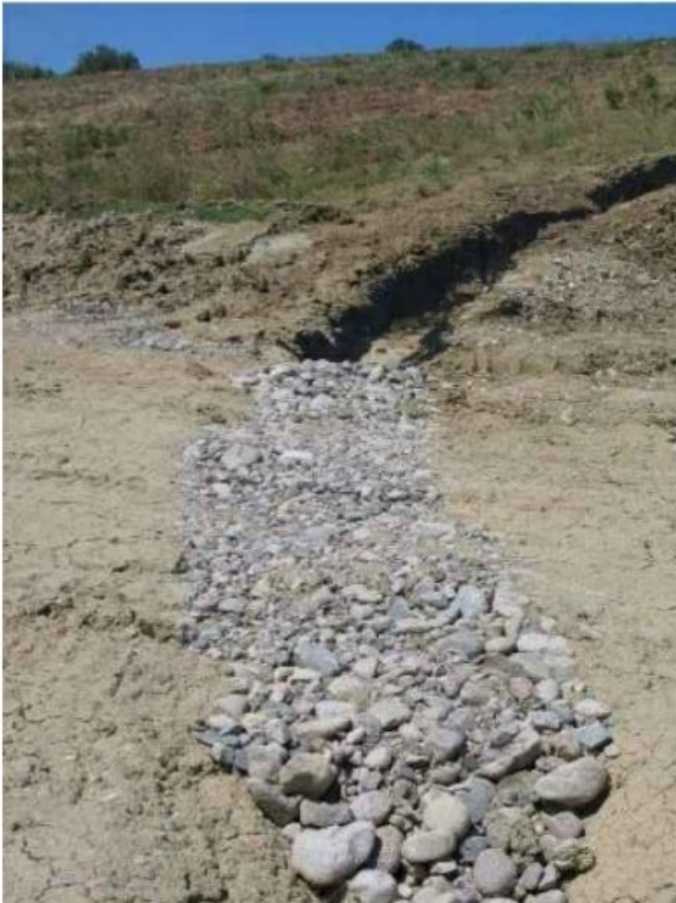
Foto 2: Drenaggi acque meteoriche
