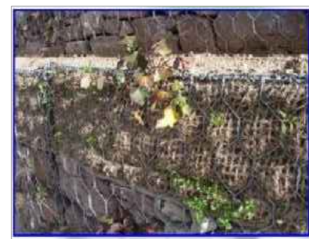
consolidamento con gabbionata rinverdit
