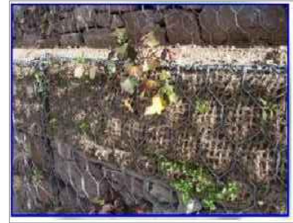
consolidamento con gabbionata rinverdit
