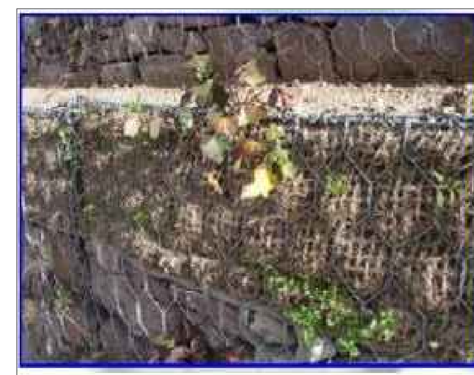
consolidamento con gabbionata rinverditata
