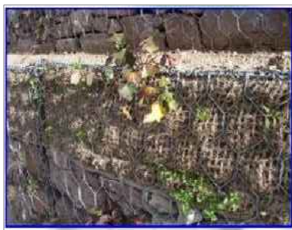
consolidamento con gabbionata rinverdit
