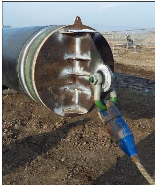
**Figura 4.27: Testa di tiro saldata alla stringa di condotta da inserire nel MT e collegamento con la fune d'acciaio collegata all'argano**
