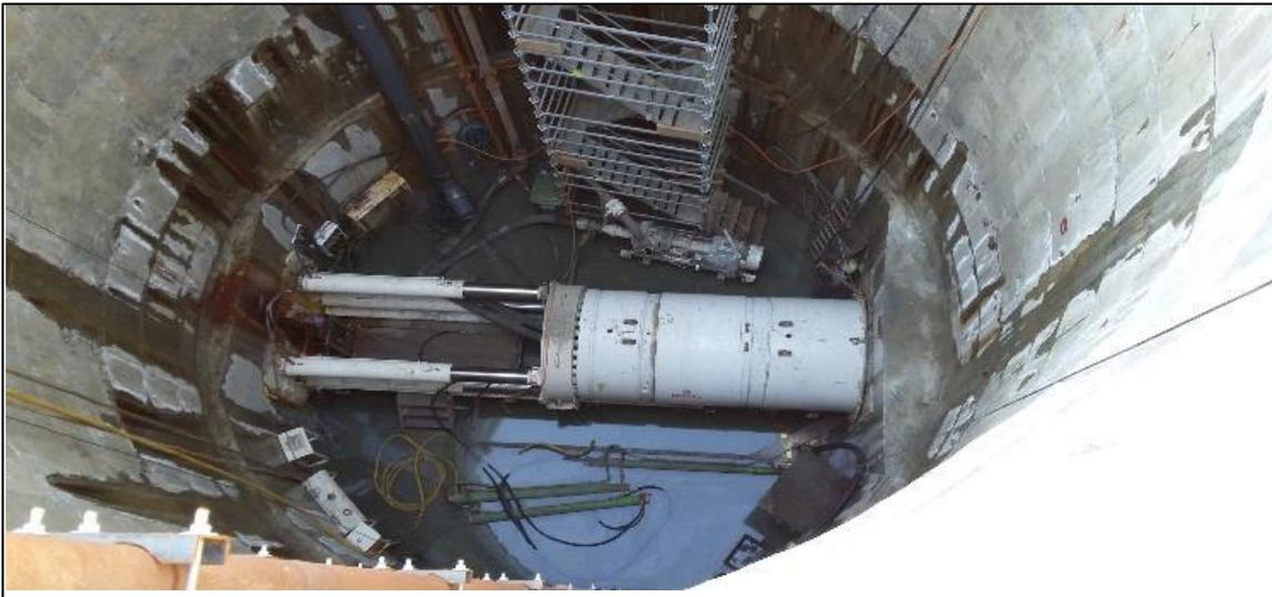
**Figura 4.21: Interno di un pozzo di lancio di un MT**
