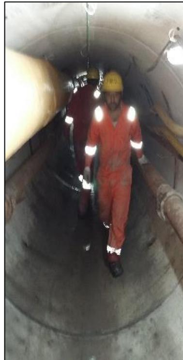
**Figura 4.22: Interno di un Microtunnel (MT) durante lo scavo**
