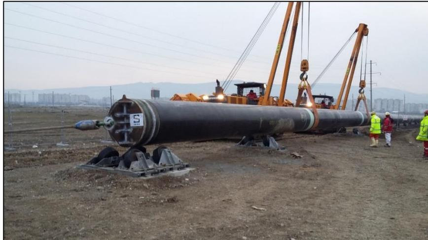
**Figura 4.28: Installazione della stringa di condotta nel microtunnel**
