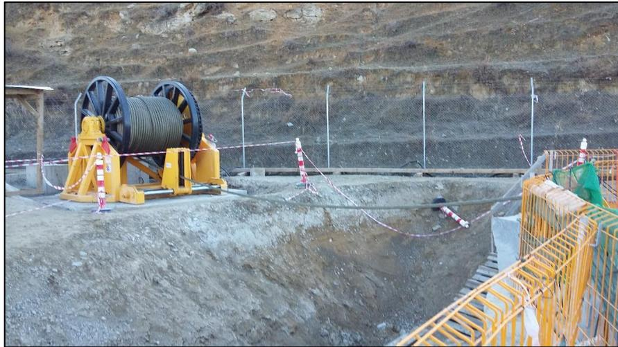
**Figura 4.24: Argano con fune d'acciaio per il tiro della condotta nel MT**
