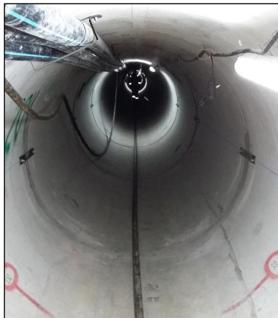
**Figura 4.25: Tunnel pronto per l'inserimento della condotta. La fune d'acciaio collegata all'argano è stesa sul fondo del MT**
