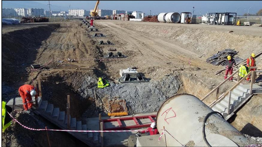
**Figura 4.26: Pozzo e rampa preparate per il varo della condotta nel microtunnel**
