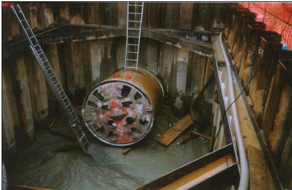
**Figura 4.23: Pozzo di recupero della fresa di un Microtunnel (MT)**
