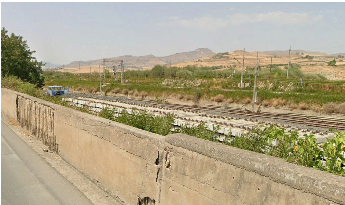
Figura 3 Deposito materiali per la manutenzione dei binari nell'area che sarà occupata dal cantiere AR.01
