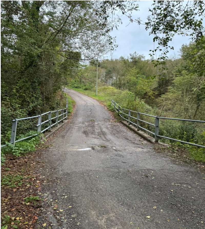
Fotografia in sezione del ponte
