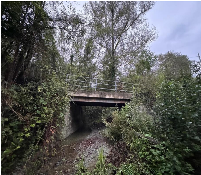
Fotografia del solaio inferiore
