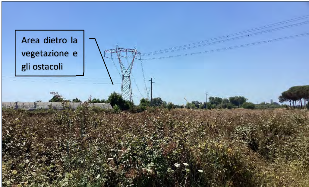
Figura 7: Stato di fatto
