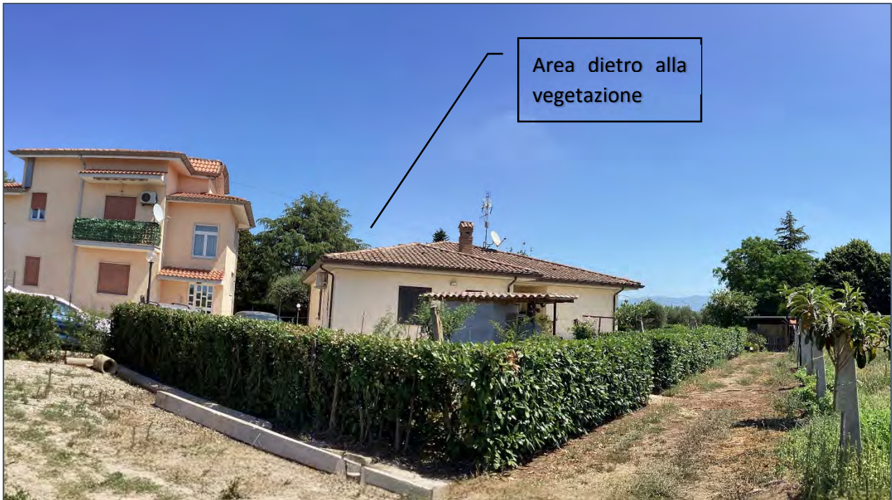
Figura 48: Stato di fatto
