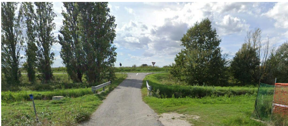
Figura 14 - Uscita del cavidotto AT dalla viabilità locale ed imbocco, dopo attraversamento di un canale di scolo, alla SP54 (verso destra)
